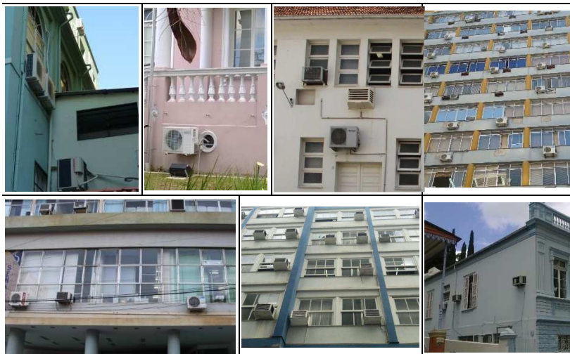
Figura 63 – Fotos de alguns sistemas de condicionamento observados nas edificações históricas
