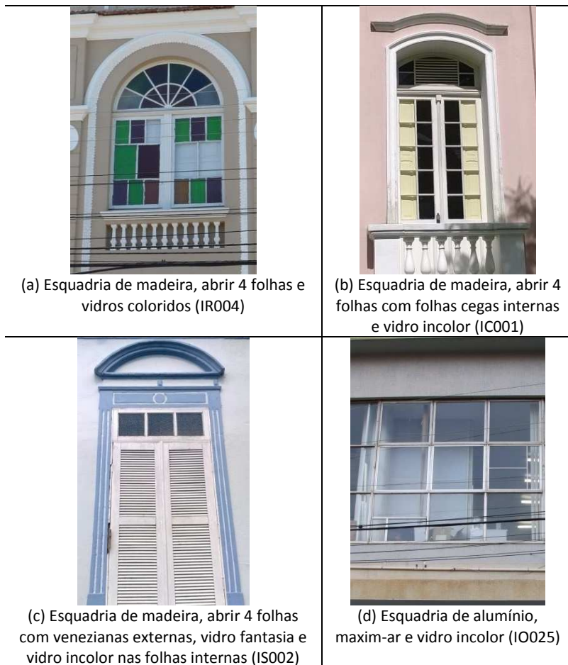
Figura 54 – Exemplos de esquadrias de madeira e alumínio com vidros coloridos e incolores
