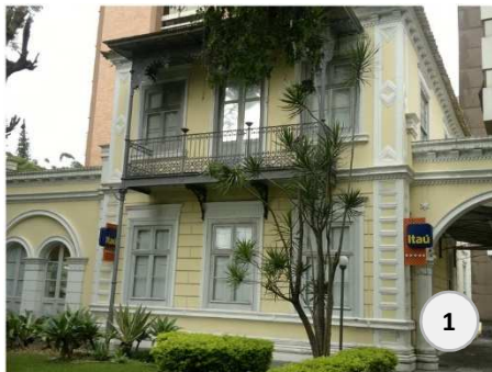
1) IB001 - CASA DO BARÃO (ITAÚ) – RUA BOCAIUVA, 1764
