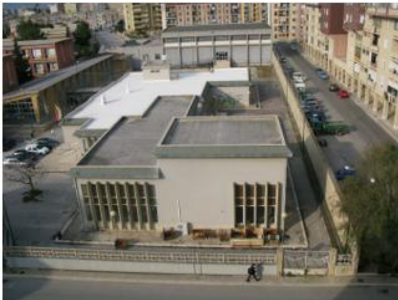
Figura 4.4 - Aplicação do tratamento para teto frio sobre a estrutura de uma escola
