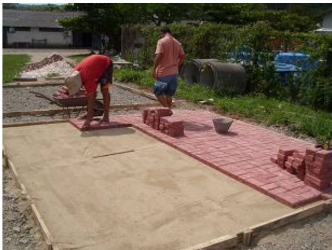
Figura 6.23 – Construção da área experimental: execução da placa de paver vermelho (d).
