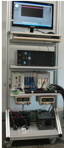
Figura 18 – Bancada para supervisão e controle de dados.
