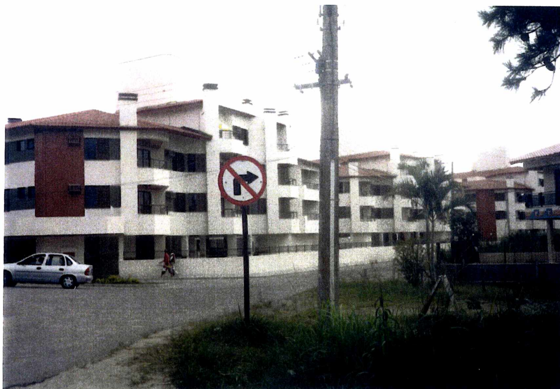
Foto 25 – Vista parcial de empreendimento imobiliário em área do Balneário Ponta das Canas, norte da Ilha de Santa Catarina – Florianópolis (Autoria: E.V. Machado, 1999).
