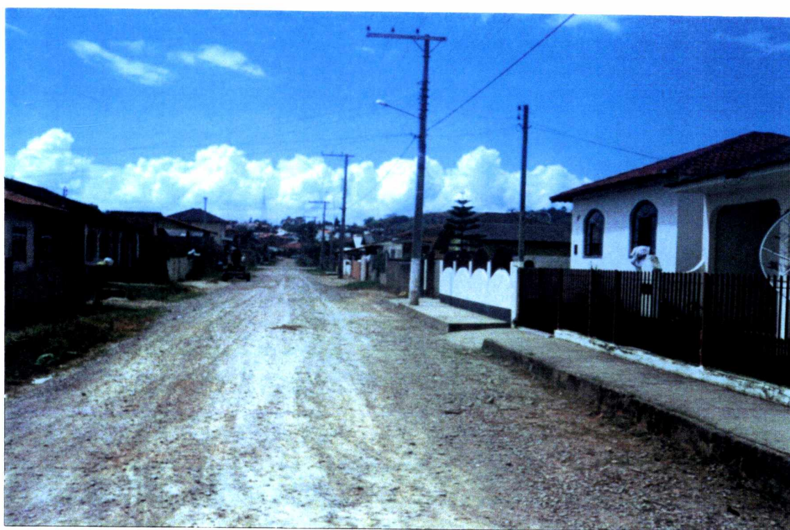
Foto 12 – Exemplo de “periferia interiorana”: Loteamento Jardim Flor de Nápolis, município de São José, área vulnerável às enchentes (Autoria: E.V. Machado, 1999).
