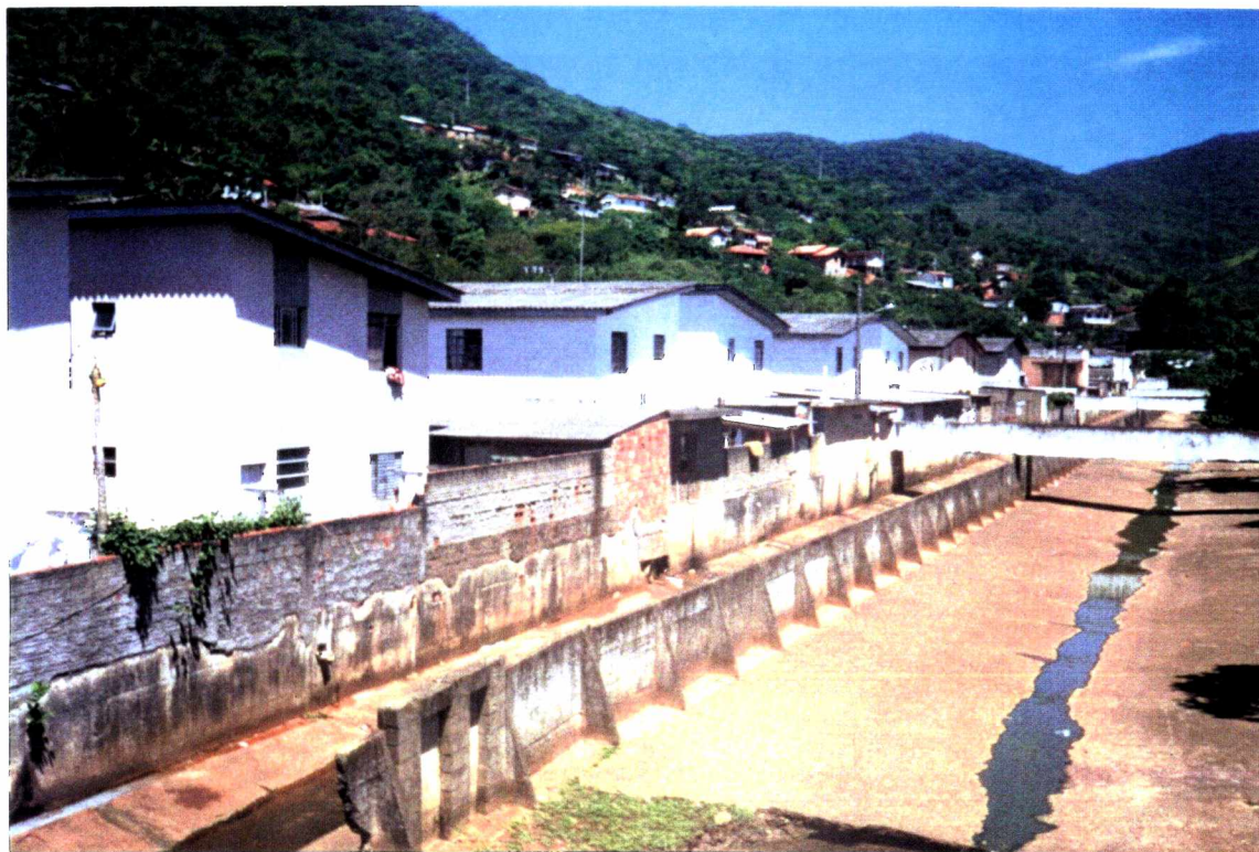
Foto 19 – Vista parcial do Conjunto Habitacional Parque da Figueira/Saco Grande II, em Florianópolis, edificado em área sujeita às enchentes (Autoria: E.V. Machado, 2000).
