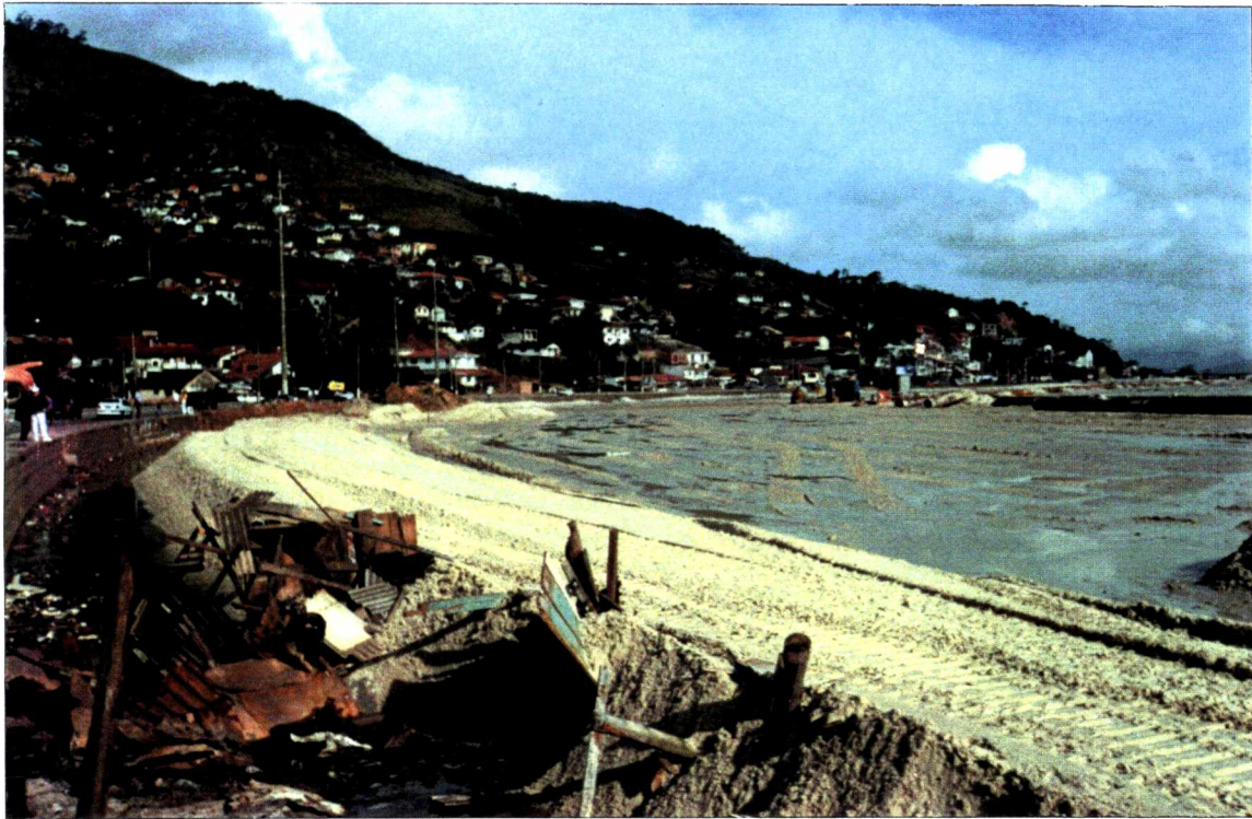
Fotos 17, a e b – Aspectos da fase inicial da obra do aterro da Via Expressa/Baía Sul, em áreas do Bairro Saco dos Limões, às margens da Rodovia SC-401/Sul, considerada um dos marcos da modernidade atual para Florianópolis (Autoria: E.V. Machado, 1996).
