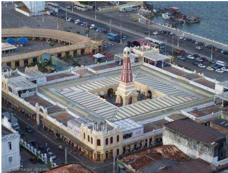
Foto 1: Vista aérea do Mercado Municipal Antônio Franco.
