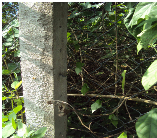
Figura 2. Cerca de Segurança. Fonte: Trabalho de campo.
