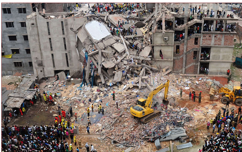
O desabamento da fábrica de roupas Rana Plaza, em Bangladesh, deixou mais de mil mortos
