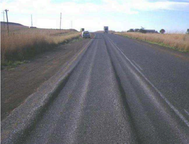
Figura 2.18 - Deformação permanente em trilha de roda.
