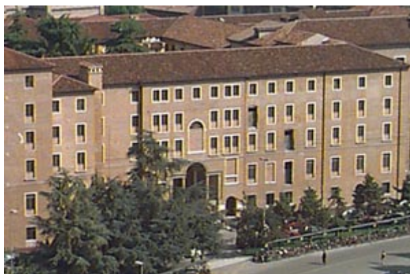
Figura 04: Visão de um dos prédios do hospital Fonte: Sítio eletrônico do hospital estudado
