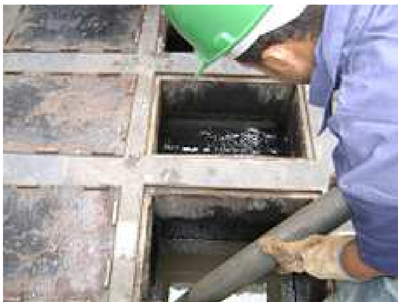
Figura 6 - Manuseio das mangueiras de coleta de óleo
