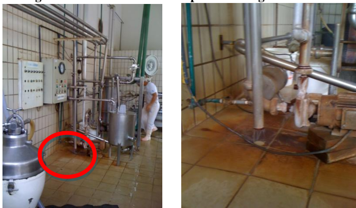
Figura 20 – Pasteurizador: desperdício de água
