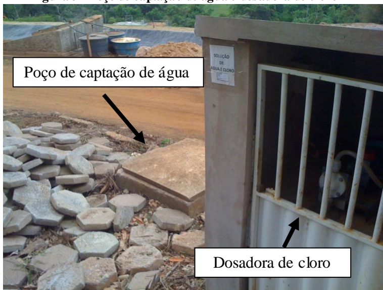
Figura 3 - Poço de captação de água e dosadora de cloro
