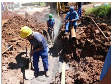
Figura 18 – Recobrimento da vala.
