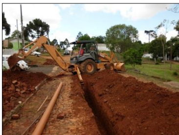
Figura 16 – Abertura mecânica de vala.
