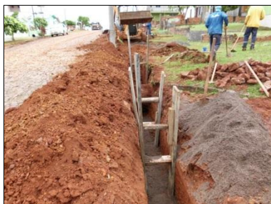
Figura 17 – Assentamento de tubulação em vala escorada.
