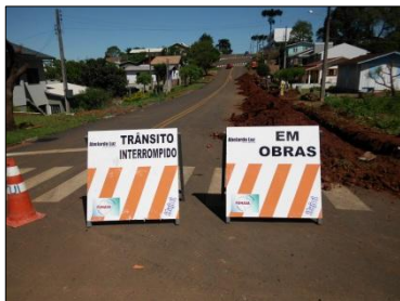
Figura 15 – Sinalização do trecho.
