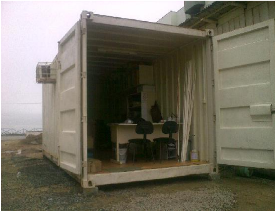
Container modificado para escritório.
