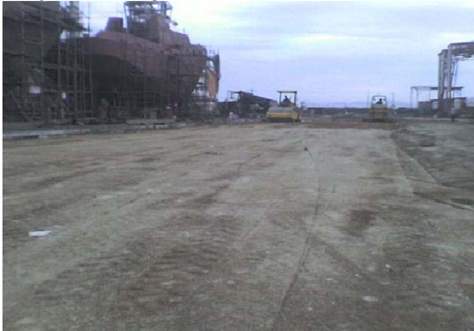
Selagem do pátio e espalhamento com trator de esteiras
