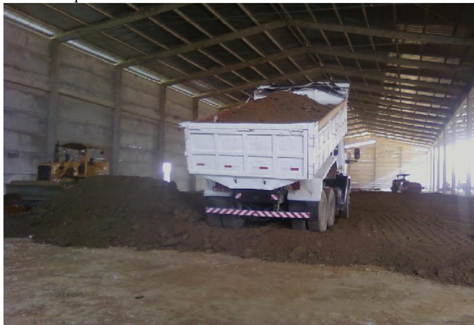
Aterro em camadas de 0,20m.
