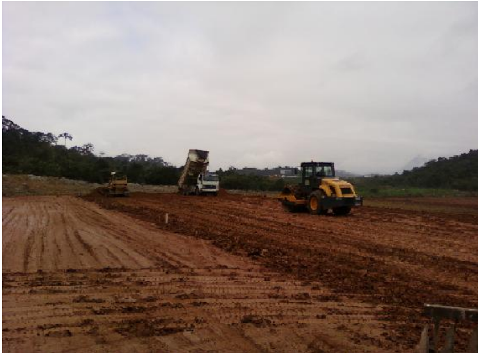
Rolo compactador, trator de esteira e caminhão caçamba
