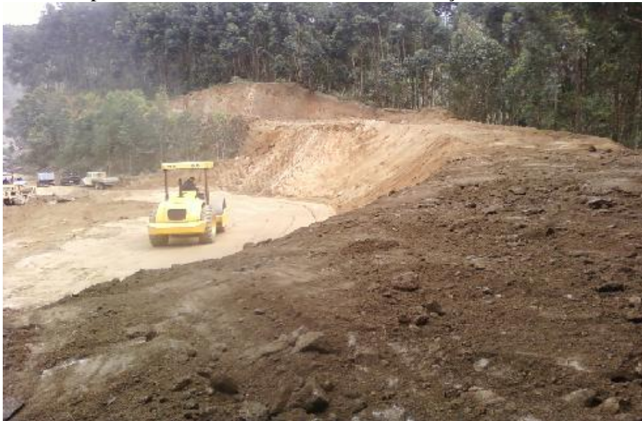
Selagem do pátio com rolo compactador liso
