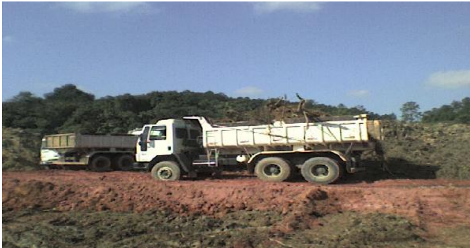
Remoção da camada vegetal
