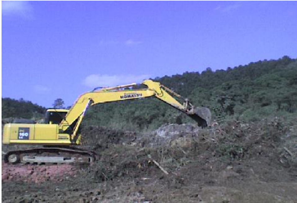
Remoção da camada vegetal
