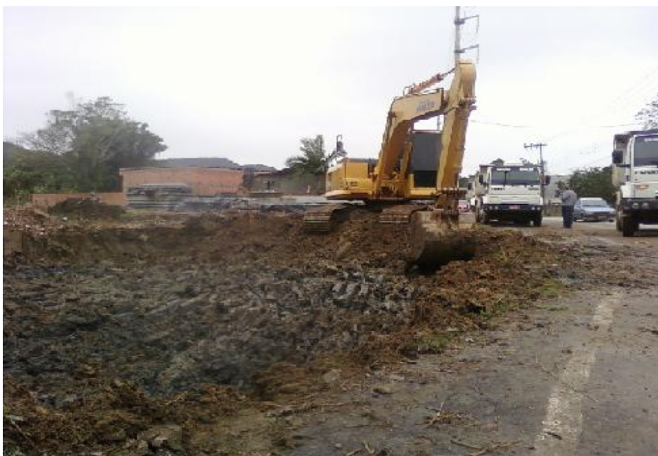
Remoção de solos moles (bota-fora)
