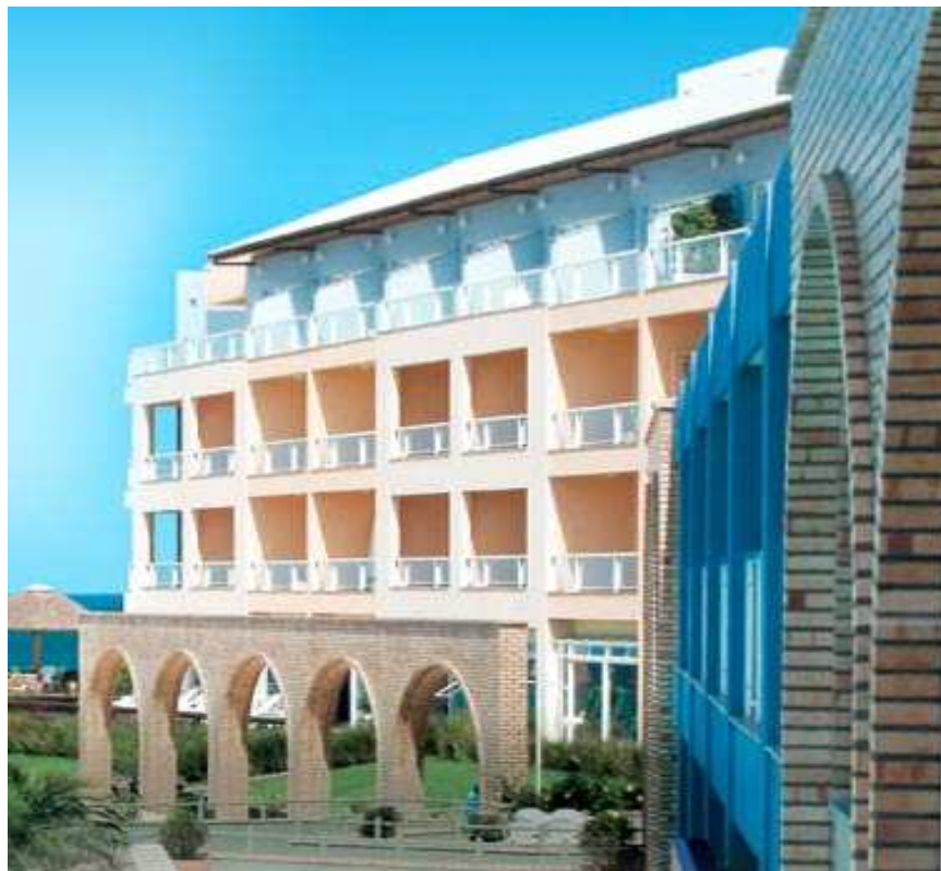
Figura 3.5: Ala Internacional do Resort. Fonte: (Costão do Santinho).
