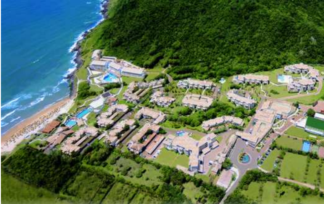
Figura 3.2: Vista aérea do Resort Costão do Santinho e parte da reserva ecológica. Fonte: (Costão do Santinho).
