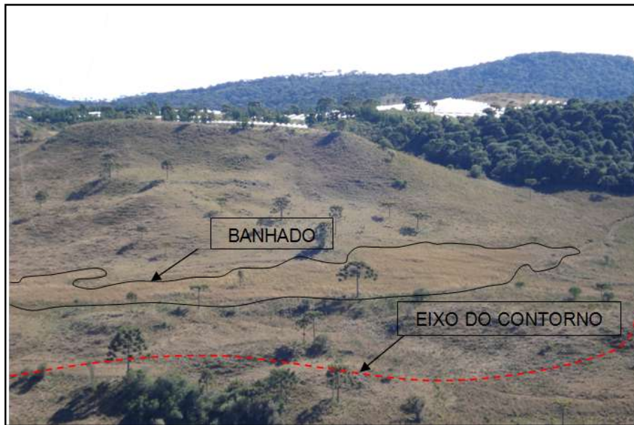
Figura 24 – Área de banhado próximo à faixa de domínio da rodovia.
