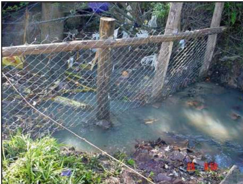
Figura 3. 7. Rede coletora de resíduo na Bacia Hidrográfica Alto da Colina. Fonte: Brites (2005)
