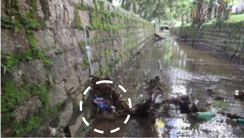
Figura 5. 2. Detalhe da abertura lateral na tela de monitoramento após primeiro evento de precipitação.
