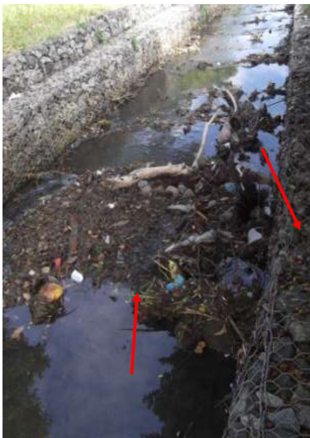
Figura 5. 6. Local onde ocorre a retenção de resíduos devido as características do fundo do canal; dependências da UFSC.
