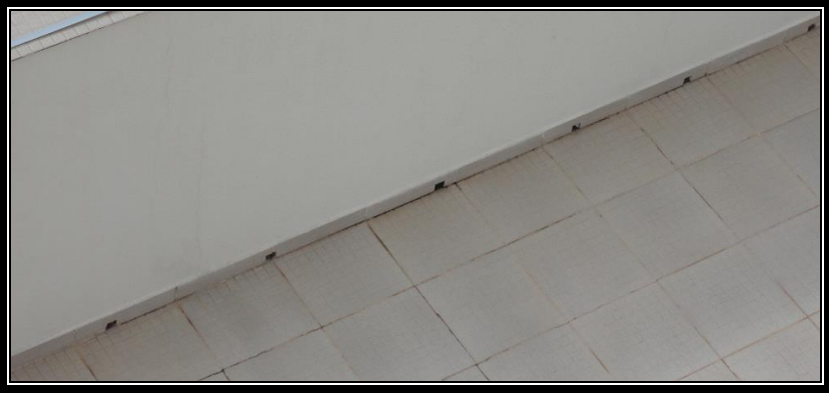
Figura 36 – Orifícios para captação de água da chuva
