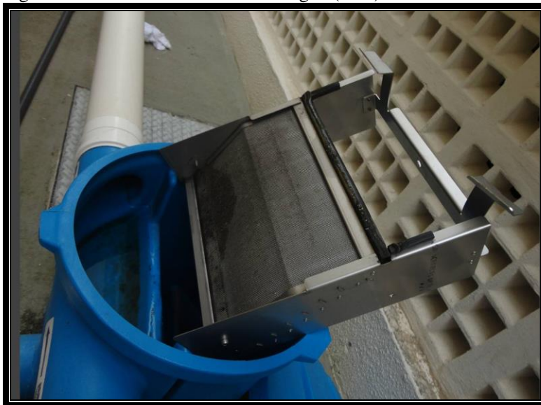
Figura 29 - Filtro com 2 entradas de água (obra)
