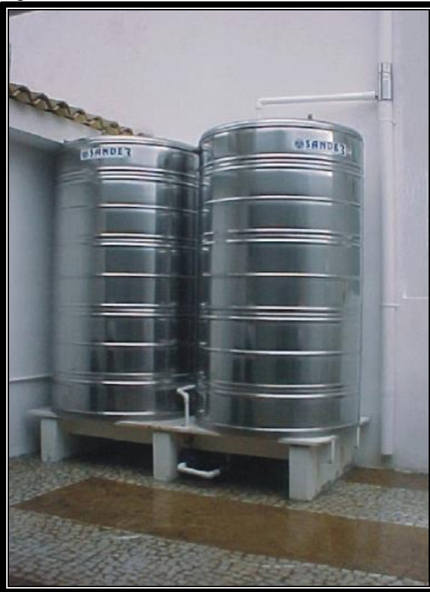
Figura 16 – Reservatório em inóx
