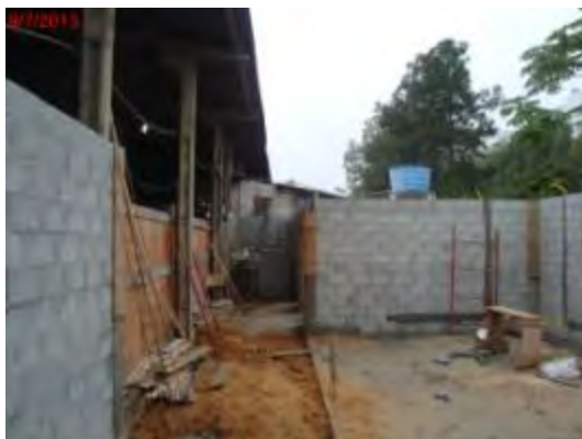
Figura 27 – Obras em andamento
