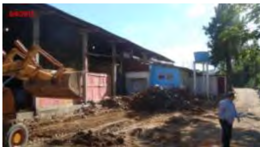
Figura 26 – Obras em andamento
