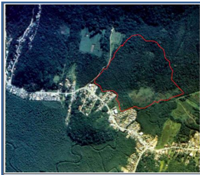
Figura 18-ASE-Área do Sistema de Saneamento e Energia.
