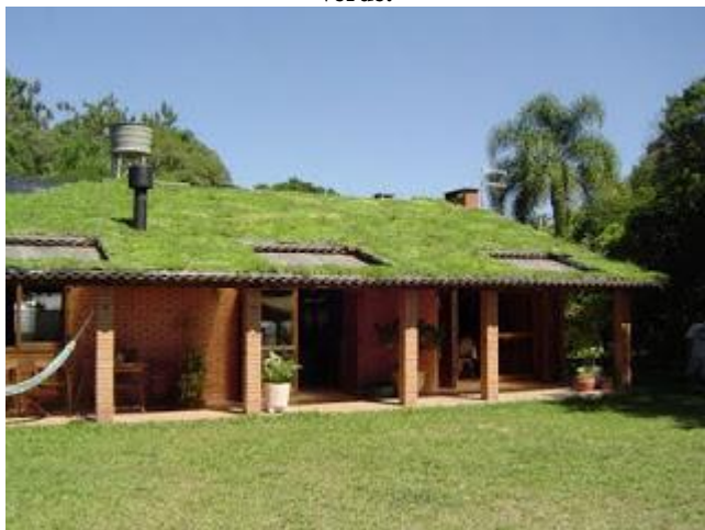
Figura 47. Exemplo de cobertura vegetal, mais conhecido como telhado verde.
