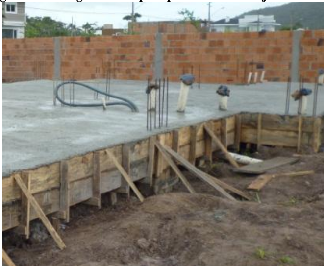
Figura 57. Passagem aberta para parte abaixo da laje de nível 0m.
