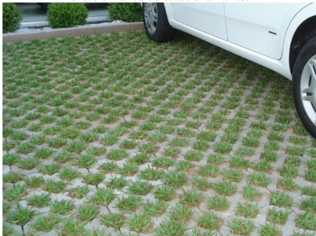
Figura 43. Exemplo de aplicação de blocos vazados pré-moldados de concreto em área de estacionamento.
