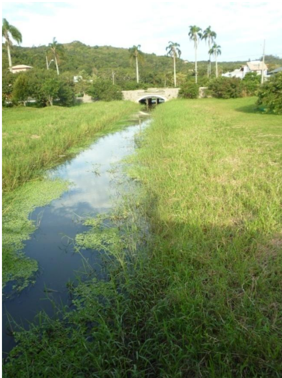
Figura 20. Foto do canal de drenagem das águas pluviais que atravessam o loteamento.
