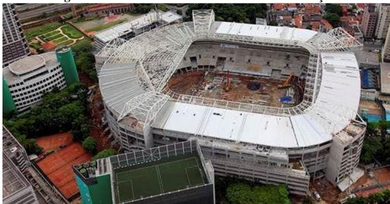
Figura 5. Arena Palestra Itália em fase de construção.
