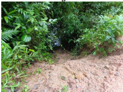
Figura 127 – Ponto de erosão na margem.
