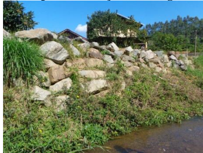
Figura 67 – Utilização de pedregulhos para contenção da margem.
