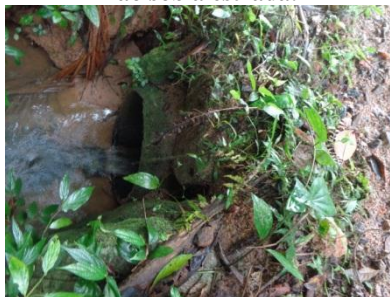
Figura 149 – Canalização do ribeirão sob a estrada.
