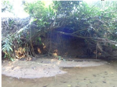
Figura 41 – Erosão na margem e acúmulo de sedimentos na margem.
