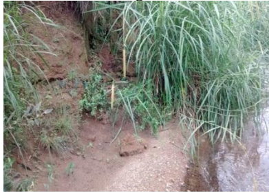
Figura 65 – Ponto de erosão na margem e acúmulo de sedimentos na margem.
