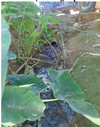
Figura 50 – Lançamento de esgoto na tubulação de água pluvial.
