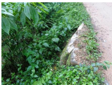
Figura 128– Contenção da margem.
