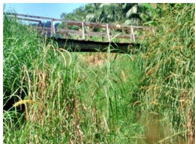
Figura 71 – Presença de travessia.
