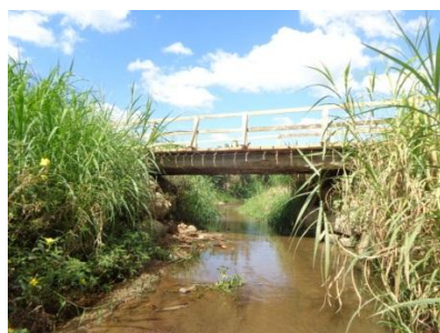
Figura 56 – Presença de travessia.
