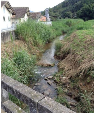
Figura 73 – Ausência de vegetação ciliar e presença de residências na margem.
