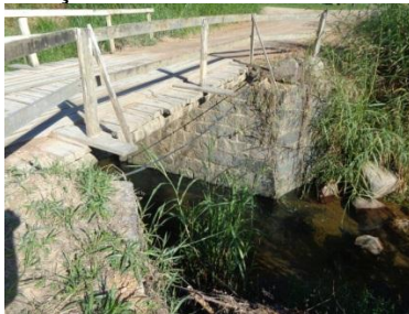
Figura 92 – Ponte estrangulando a seção transversal do ribeirão.
