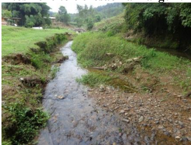
Figura 108 – Acúmulo de sedimentos no leito e erosão na margem.
