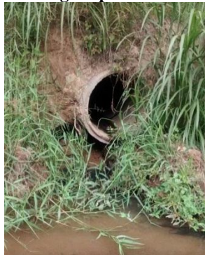
Figura 69 – Lançamento de efluente em conjunto com a tubulação de águas pluviais.
