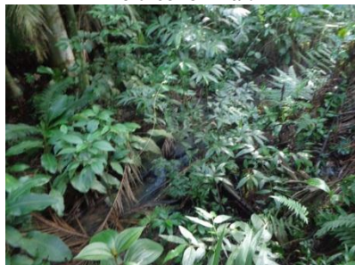
Figura 148 – Presença de vegetação no trecho final.
