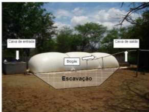
Figura 5 - Lagoa anaeróbia coberta.
