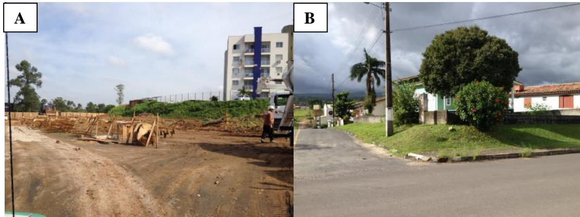
Figura 8. Vistorias. A) Fiscalização de empreendimento que solicitou a Autorização Ambiental (AuA) para a atividade de terraplanagem. B) Empreendedor solicitou AuA para realizar a atividade de Desmembramento. Fotos do autor – Abril de 2014.
