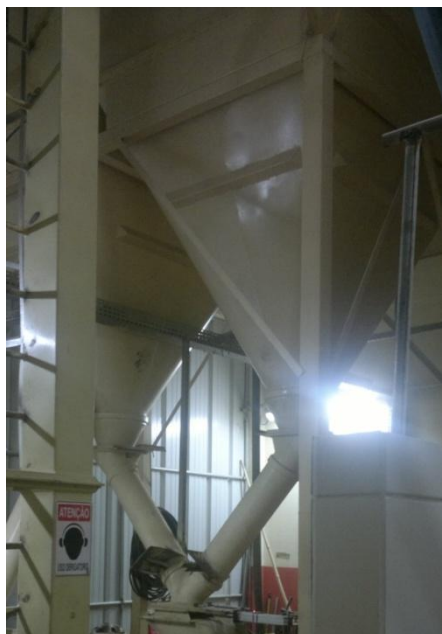
Figura 6. Tulhas de Armazenagem do Moinho. Fonte: Registro fotográfico do autor, 2014.
