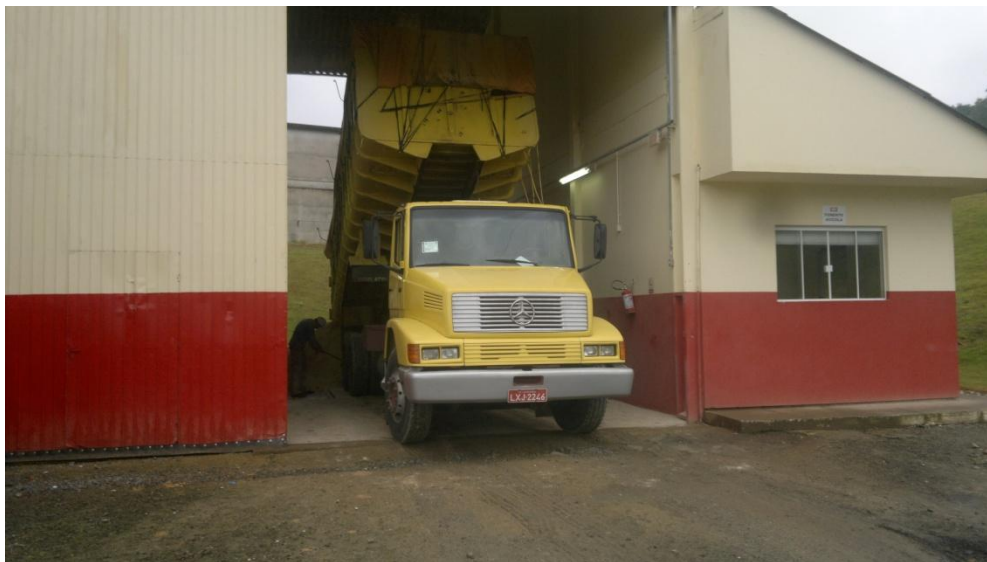
Figura 3. Moega de Descarga de Macro ingredientes. Fonte: Registro fotográfico do autor, 2014.
