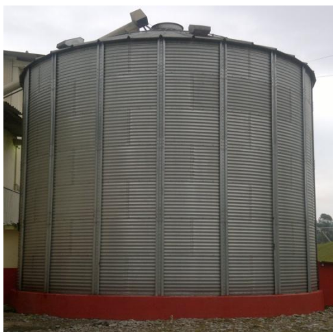
Figura 4. Silo Externo de Armazenagem de Milho. Fonte: Registro fotográfico do autor, 2014.
