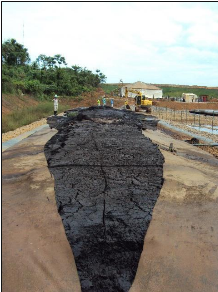
Figura 7: Abertura das geofôrmas para retirada do lodo
