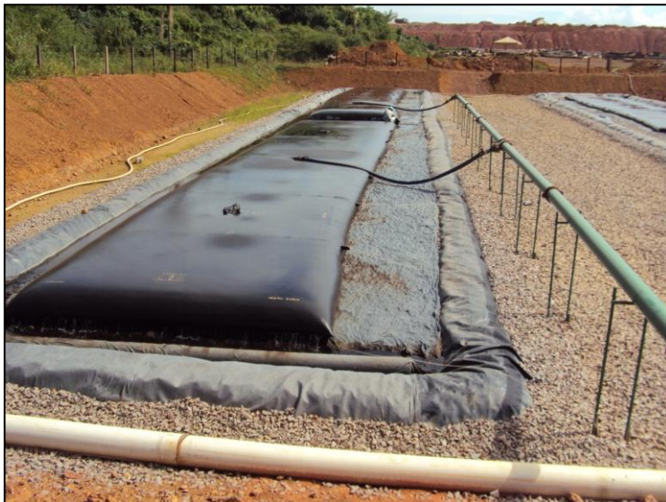
Figura 6: Tratamento de lodo – Geofôrmas HaTe tube
