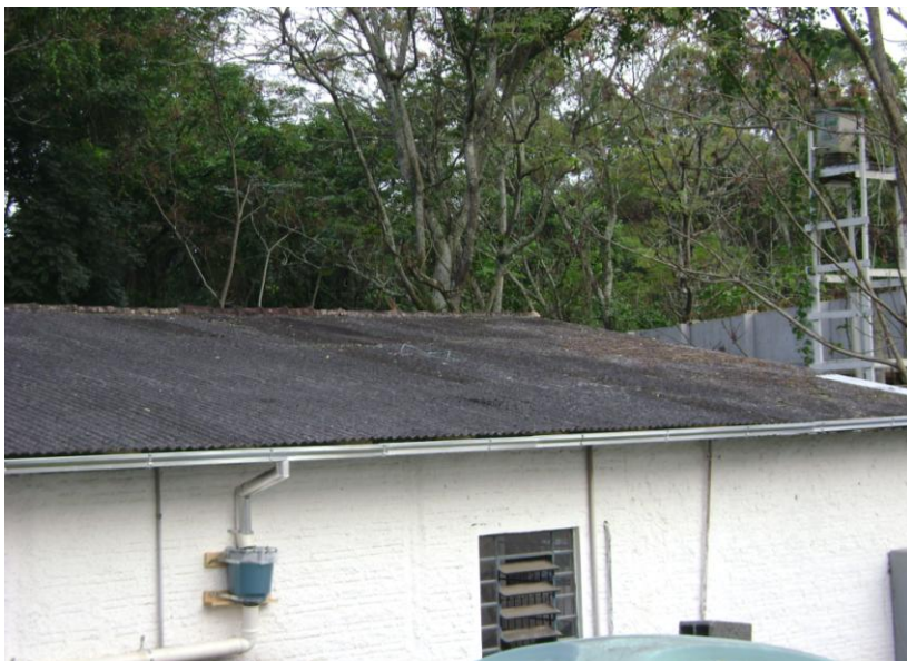
Figura 15 - Telhado do laboratório de hidráulica
