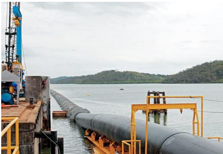
Figura 5 - Assentamento da tubulação (em PEAD) do emissário submarino de Salvador-BA.
