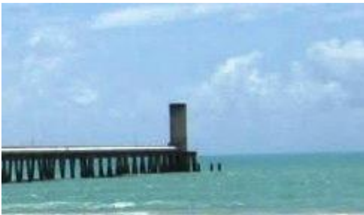
Figura 6 - Chaminé de Equilíbrio do SDO de Maceió. Fonte: TAVARES (2010).
