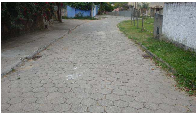
Figura 7 - Drenagem urbana na microárea 06
