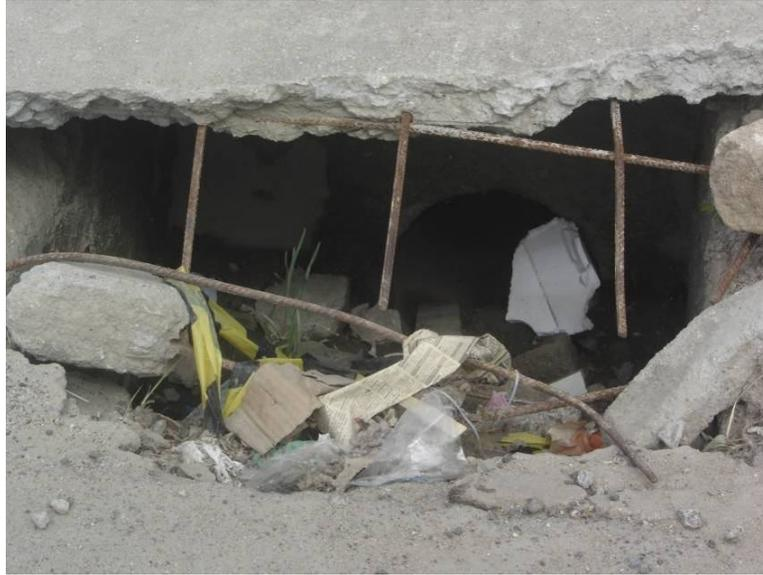
**Foto 5:** Caixa coletora para drenagem, problemas com armadura exposta, alvenaria quebrada e obstrução por diferentes materiais.
