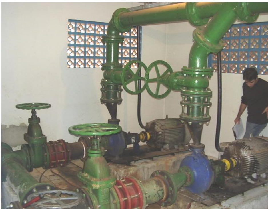
Figura 5.11 – Estação elevatória CB-09.
