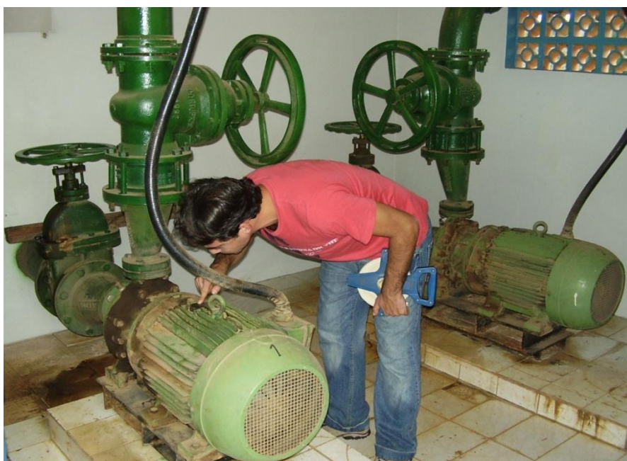
Figura 5.12 – Estação elevatória CB-10.
