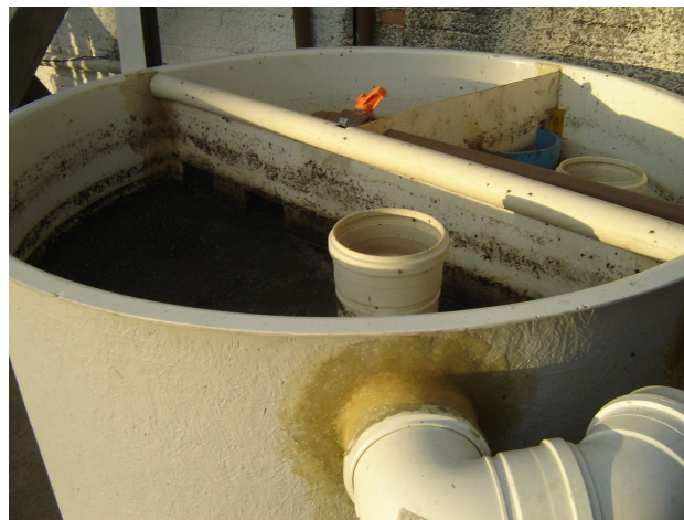
Figura 2: Tanque séptico subdividido em três câmaras.
