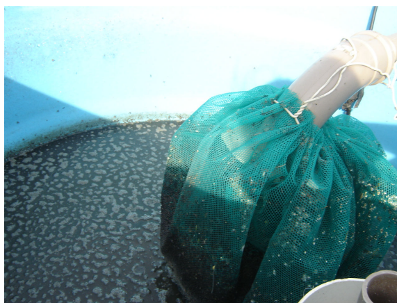
Figura 9: Tela de proteção na entrada do reservatório superior.
