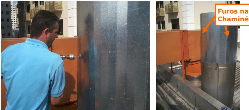
Figura 9 – Furos na chaminé: (a) Momento da execução, (b) prolongamento da chaminé com furos.
