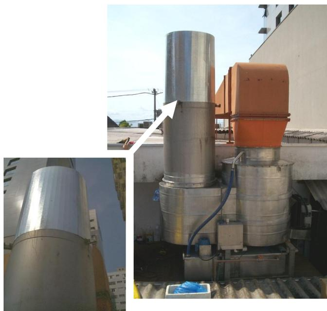
Figura 7 – Prolongamento da chaminé do lavador de gases.
