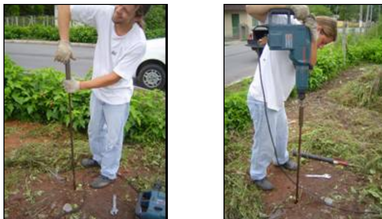
Figura 21 - Perfuração dos poços de monitoramento
