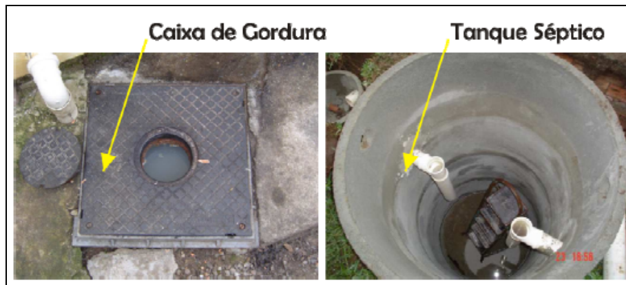
Figura 14 - Vista superior caixa de gordura e do tanque séptico.
