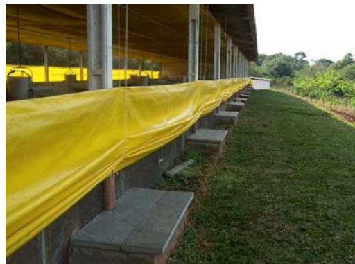
Figura 1: Foto que mostra um canal externo coberto evitando a proliferação de moscas, odores e infiltração da água da chuva. Fonte: OLIVEIRA (2004).
