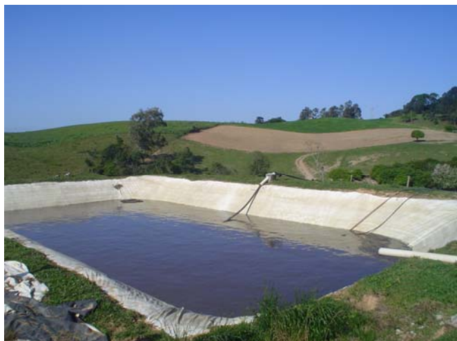
Figura 19 – Esta foto mostra que a esterqueira, da propriedade em estudo, que recebe o efluente do biodigestor não possui canaletas de drenagem da água pluvial. Fonte: Vamblê, outubro de 2007.
