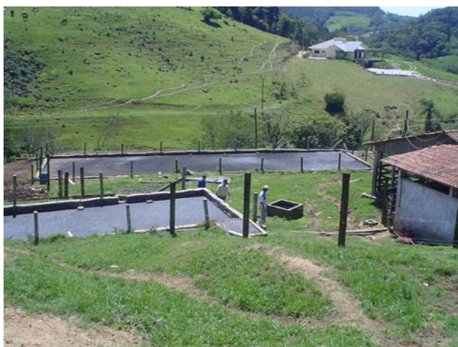
Figura 27 – Esta foto mostra que a esterqueira, da propriedade em estudo, não possui canaletas de drenagem da água pluvial. Fonte: Vamblê, outubro de 2007.
