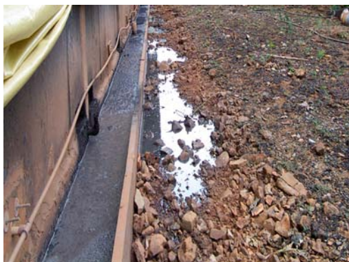
Figura 3: Foto que mostra canal externo aberto usado frequentemente para o manejo dos dejetos. Fonte: OLIVEIRA (2004).
