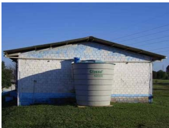
Figura 4: Foto que mostra o sistema de calhas do telhado ligadas a uma caixa d'água. Fonte: OLIVEIRA e SILVA (2006).
