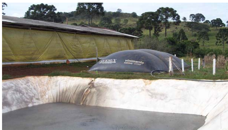
Figura 6: Foto de um biodigestor, modelo canadense. Fonte: OLIVEIRA (2004).
