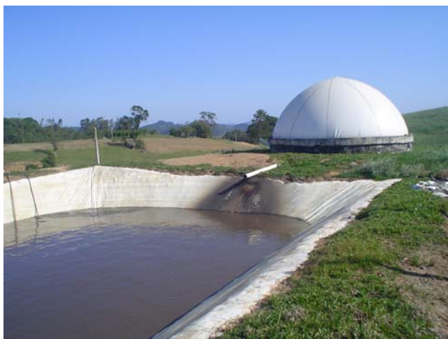
Figura 20 – Foto que mostra o biodigestor, da propriedade em estudo, e a esterqueira que recebe seu efluente. Fonte: Vamblê, outubro de 2007.
