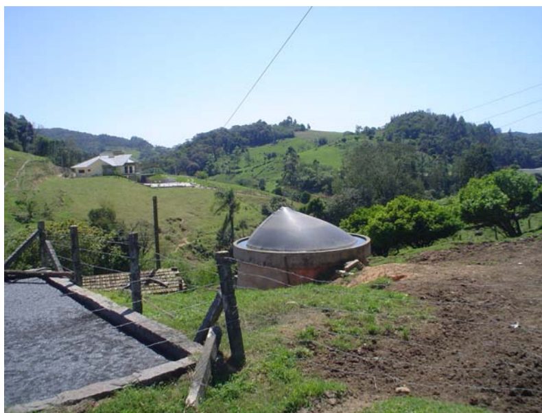
Figura 29 – Foto que mostra o biodigestor, da propriedade em estudo, e a esterqueira que recebe seu efluente. Fonte: Vamblê, outubro de 2007.
