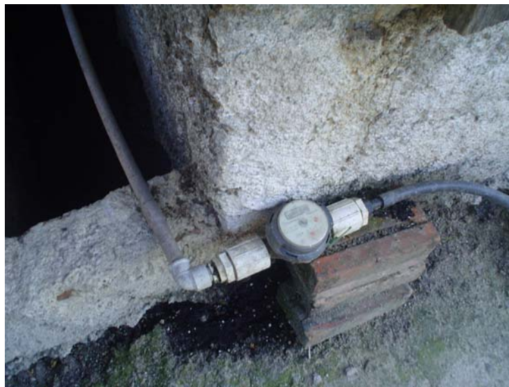
Figura 18: Foto que mostra o hidrômetro de umas das baias da propriedade. Fonte: Vamblê, outubro de 2007
