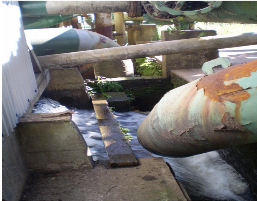
Figura 12 - Transbordo de volta ao corpo receptor. Vazão média de 300 m<sup>3</sup>/h
