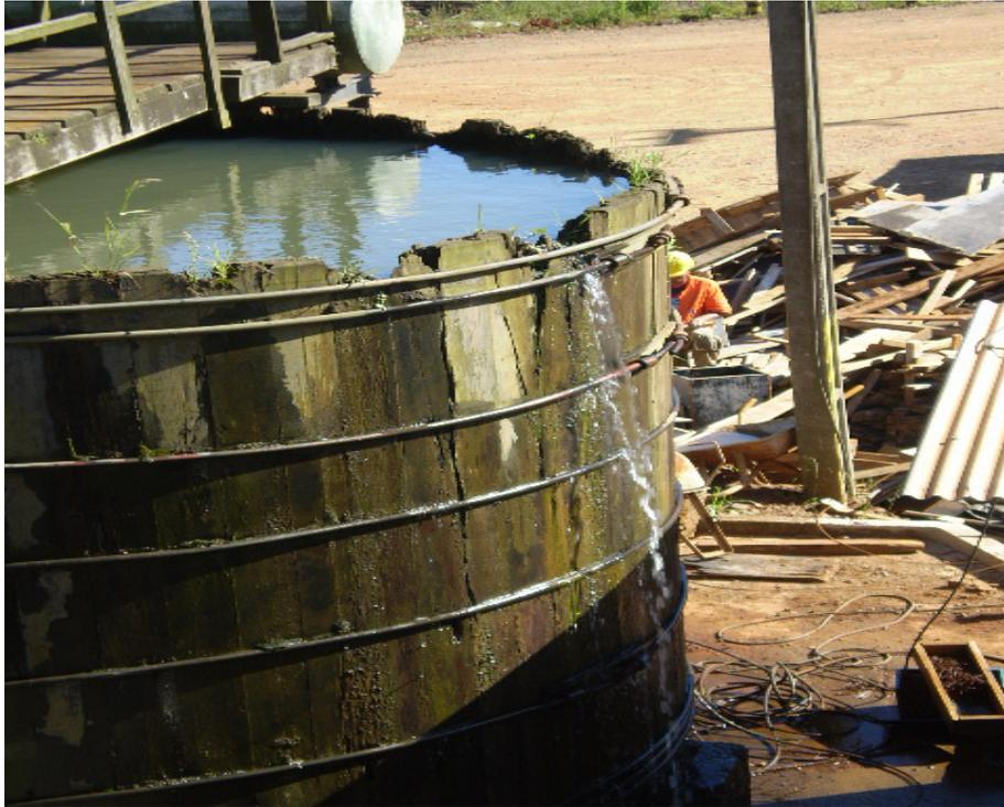
**Figura 8 - Detalhe do vazamento do filtro**
