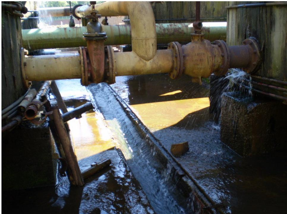
**Figura 7 - Detalhe do vazamento do filtro**
