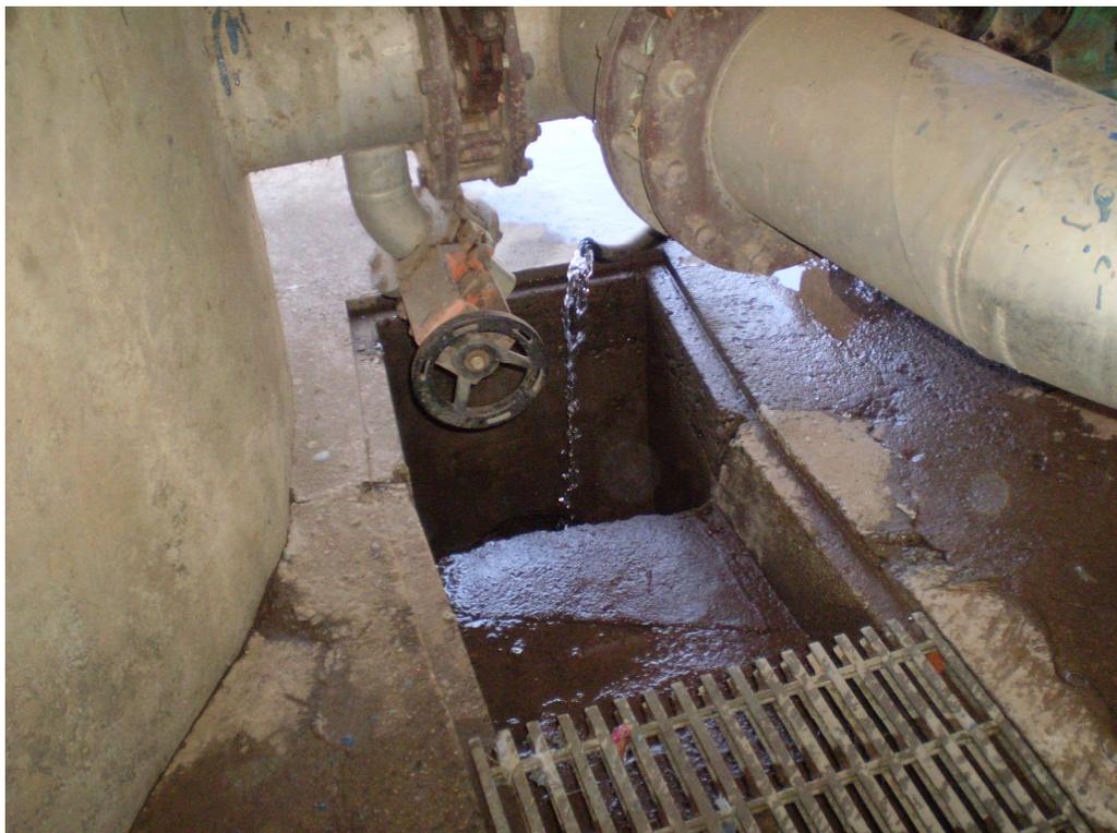
**Figura 19 - Ponto 6: Vazamento das Gaxetas - torre 2.**
