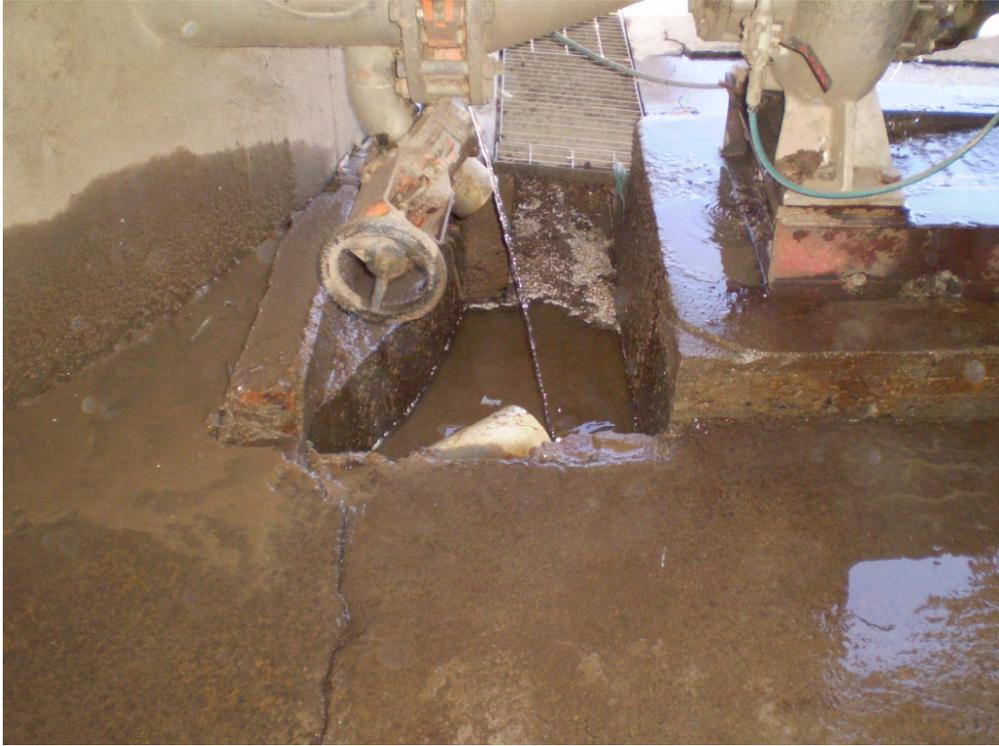
**Figura 18- Ponto 5: Vazamento das Gaxetas - torre 1.**
