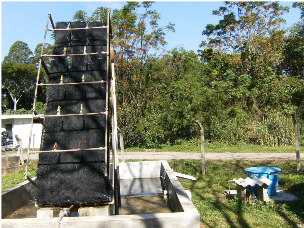
Figura 5 – Imagem do piloto experimental de tratamento de lixiviados por evaporação natural
