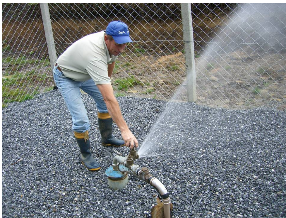
Figura 10 – Poço Artesiano de Lomba Alta
