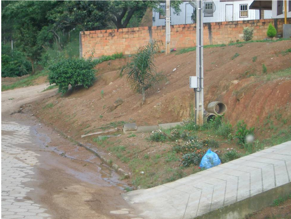
Figura 16 – Drenagem desconexa em Águas Frias
