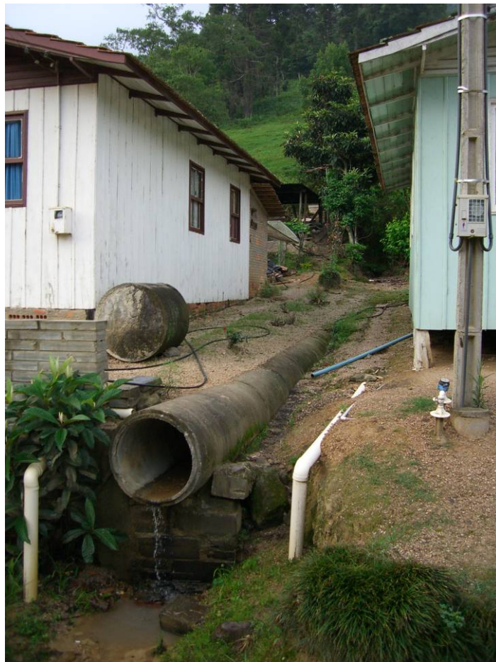
Figura 17 – Drenagem desconexa em Caeté
