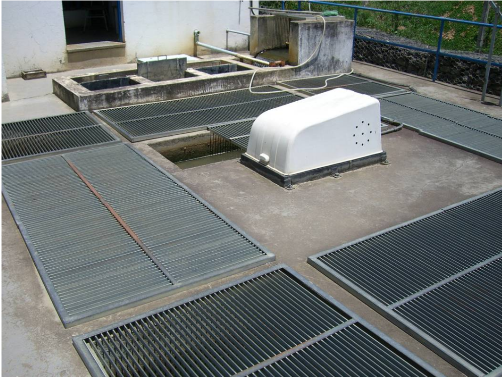
Figura 7 – Estação de Tratamento de Água da CASAN do tipo SANEPAR-CEPIS
