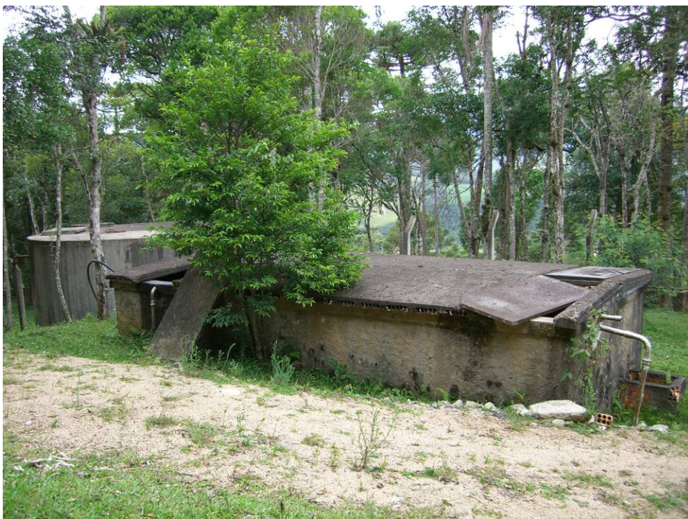
Figura 9 – Estação de Tratamento de Água de Demoras – Tanque contato (s/cloração) e reservatório (s/ uso)
