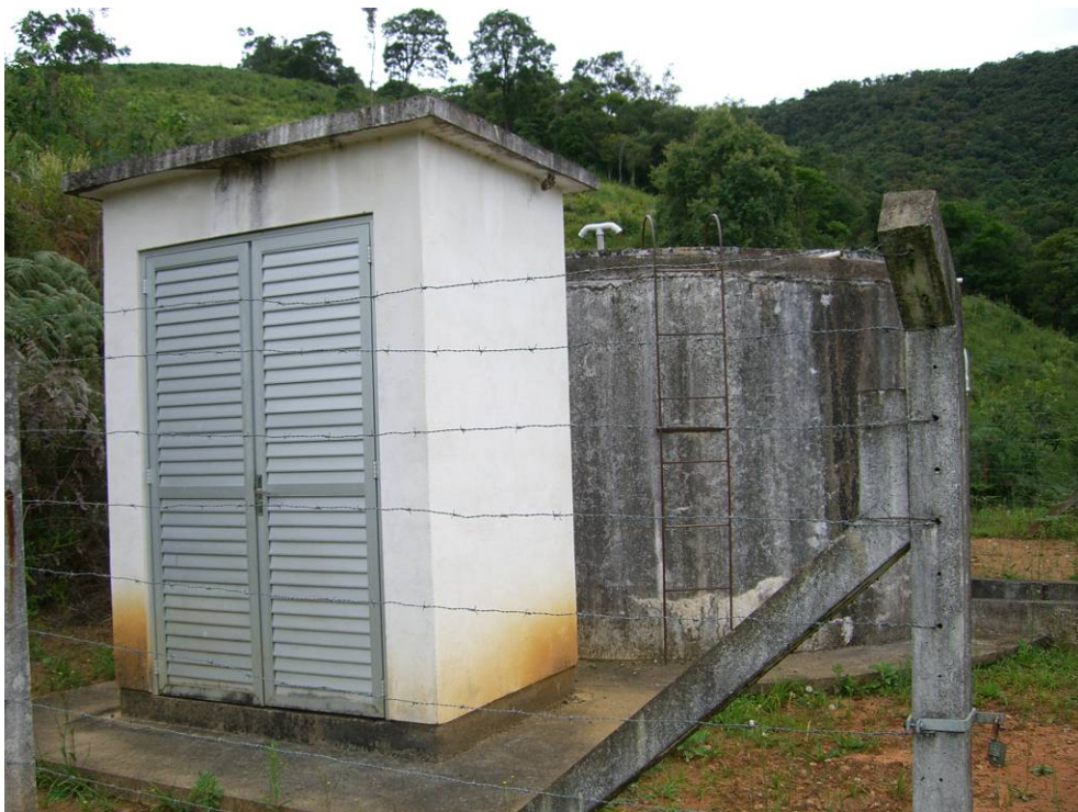
Figura 12 – Na primeira vista, o dosador de cloro (s/funcionamento) e ao fundo o reservatório; em Catuíra
