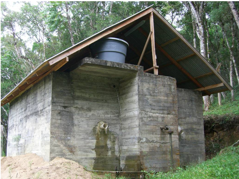
Figura 8 – Estação de Tratamento de Água de Demoras – Filtros lentos
