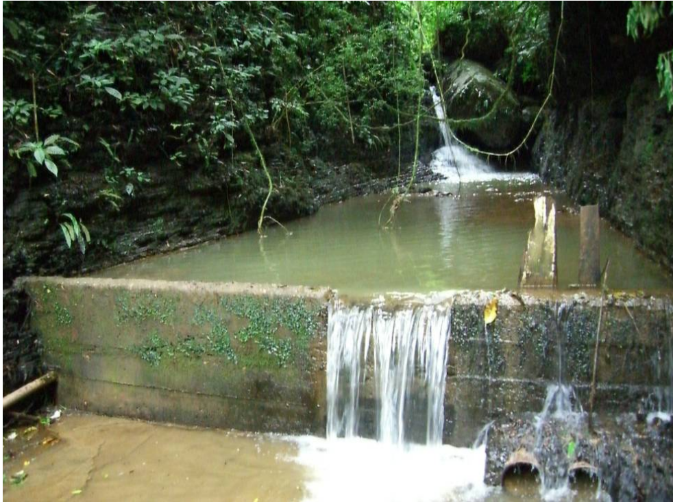
Figura 11 – Local de Captação de Água de Catuíra funcionando apenas para contenção
