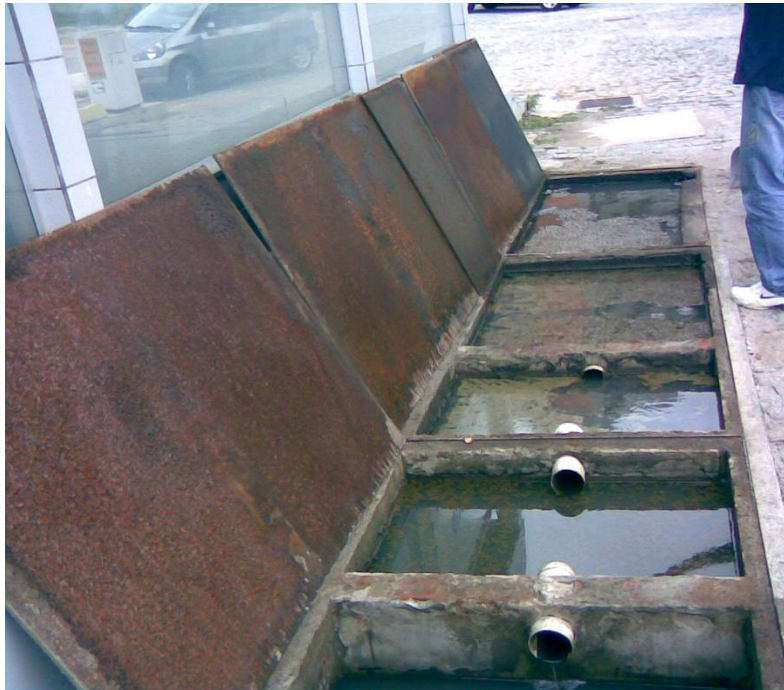
Figura 10: Sistema separador de água e óleo convencional do Posto PSJ
