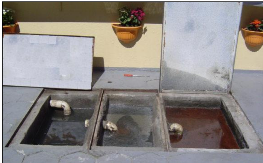
Figura 2: Sistema Convencional Separador de Água e Óleo.
