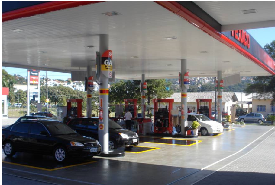
Figura 15: Vista da pista de abastecimento dotada de calha coletora do Posto Sulcar.
