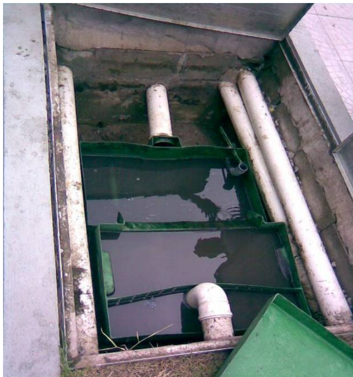
Figura 16: Sistema SAO de caixa pré-fabricada do posto Sulcar.
