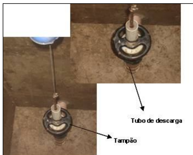
Figura 8 – Foto do Detalhamento do tubo de descarga e tampão.
