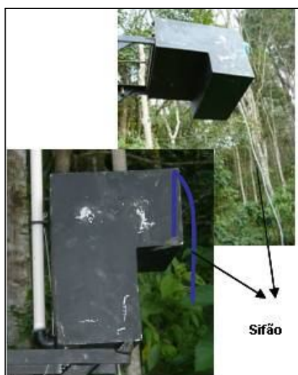
Figura 30 – Foto da alocação do sifão e sifão em funcionamento.
