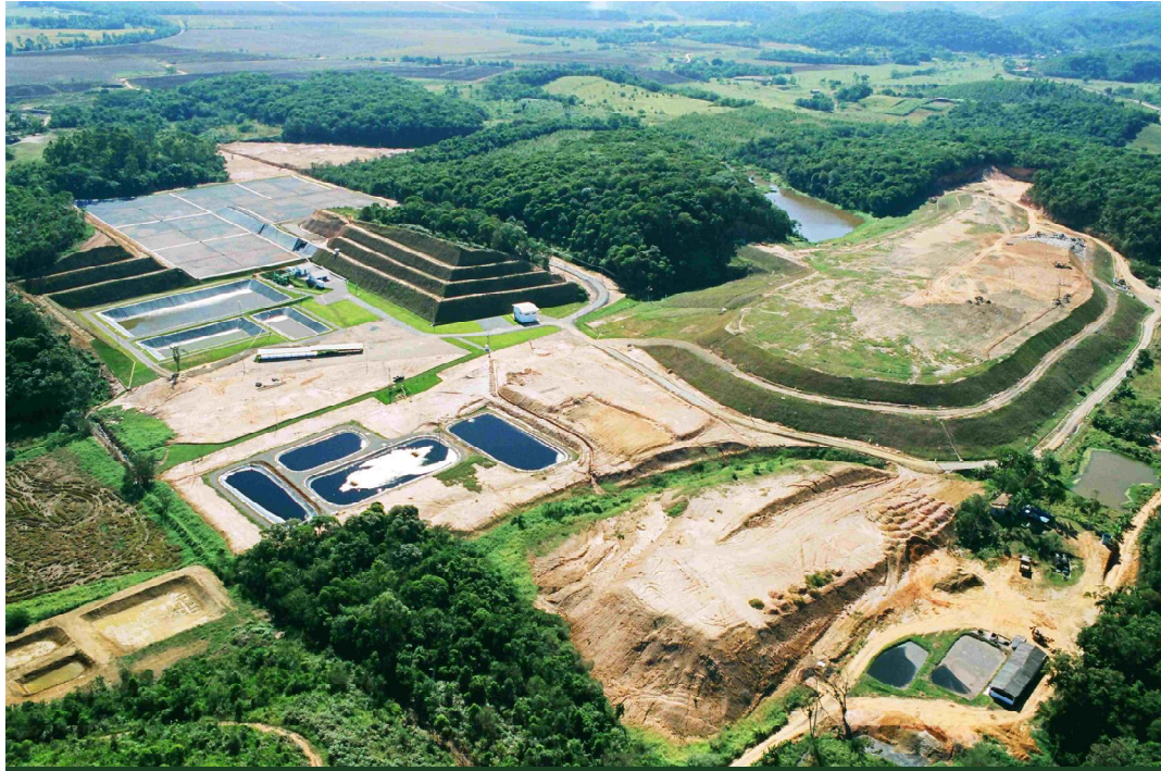
Figura 10 - Foto aérea do Aterro Sanitário Canhanduba FONTE: Foto cedida pela empresa AMBSC.
