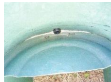
Figura 33: Selando a parte de cima do separador
