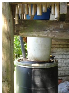
Figura 7: Tubo de ventilação acoplado na bombona.
