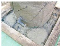
Figura 30: Arames colocados para reforço
