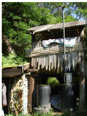
Figura 6: Vista seção norte com bombonas em uso.
