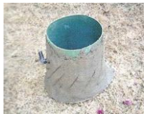
Figura 28: Concretando a outra metade do balde
