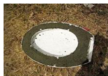
Figura 24: Adição de cimento na parte de dentro do acento
