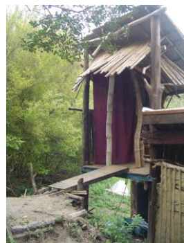
Figura 5: Rampa de entrada e cortina.
