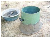
Figura 27: Concretando o balde até a metade
