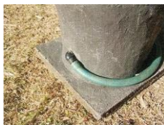
Figura 34: Tubo de saída da urina conectado
