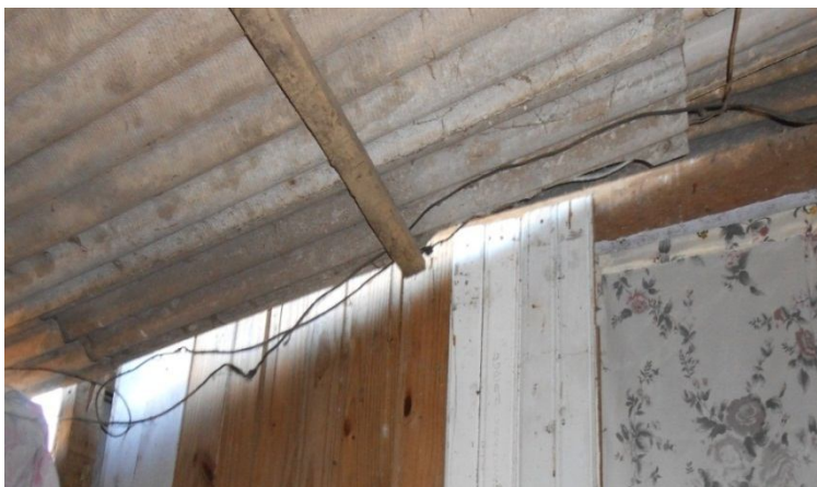
Figura 8- Fiação elétrica feita pelos próprios moradores
