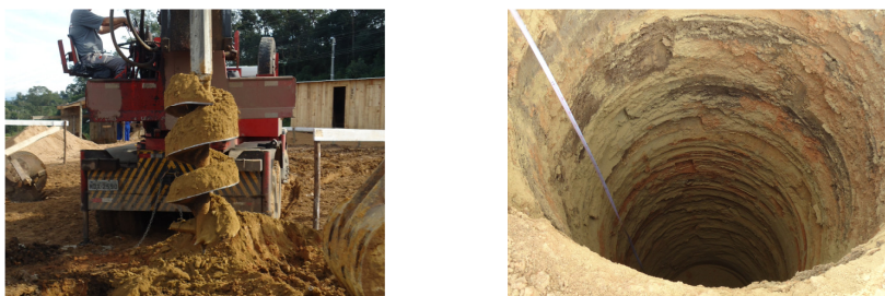
Figura 79 – a) Broca iniciando a perfuração. b) Perfuração pronta aguardando a armadura e concretagem.
