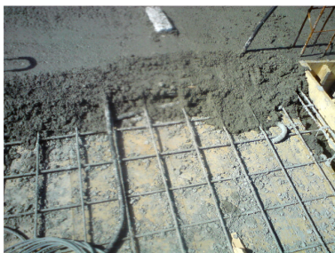
Figura 81 – a e b) Contrapiso armado resistente ao tráfego de veículos.
