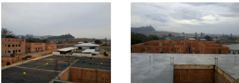
Figura 132 – a e b) Laje maciça e colunas e vigas de concreto com armadura.
