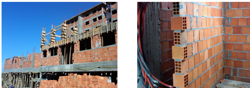
Figura 84 – a e b) Alvenaria de vedação com blocos cerâmicos de 8 furos.
