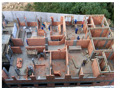
Figura 82 – a) Laje concretada e formas dos pilares em madeira do Bloco B. b) Bloco A ao fundo com sistema de vigas e pilares.
