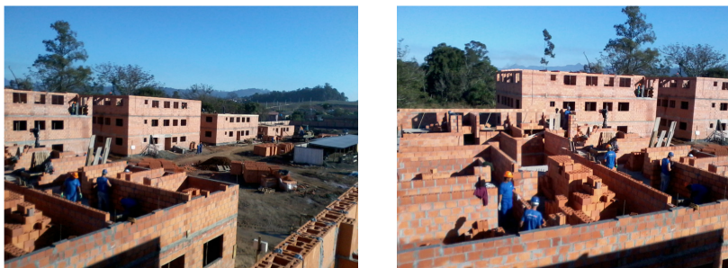
Figura 133 – a e b) Alvenaria de vedação com blocos cerâmicos de 8 furos.
