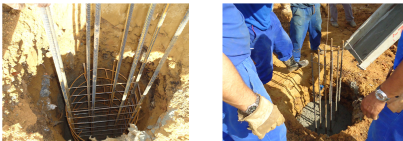
Figura 80 – a) Colocação da armadura. b) Concretagem e colocação das esperas do pilar.
