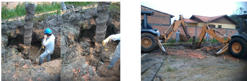
Figura 131 – a) Perfuração por broca. b) Escavação.
