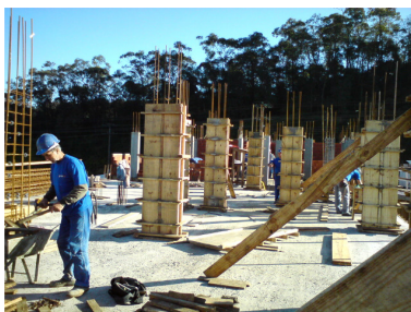
Figura 82 – a) Laje concretada e formas dos pilares em madeira do Bloco B. b) Bloco A ao fundo com sistema de vigas e pilares.
