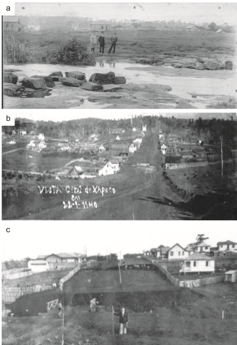
Figura 19 – a) Ponte lajeado Passo dos Índios, década 1930; b) Vista geral Chapecó início década 1940 (norte-sul); c) Lajeado Passo dos Índios na década 1930
