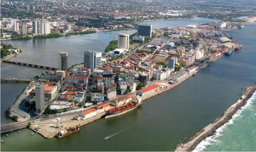
Figura 17 – Vista aérea do Porto Digital
