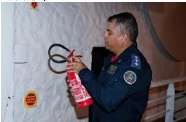
Figura 11 - Bombeiro catarinense vistoriando um Sistema Preventivo por Extintores (SPE).
