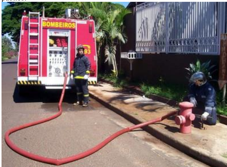
Figura 9 - Bombeiro realizando reabastecimento do caminhão em hidrante público.
