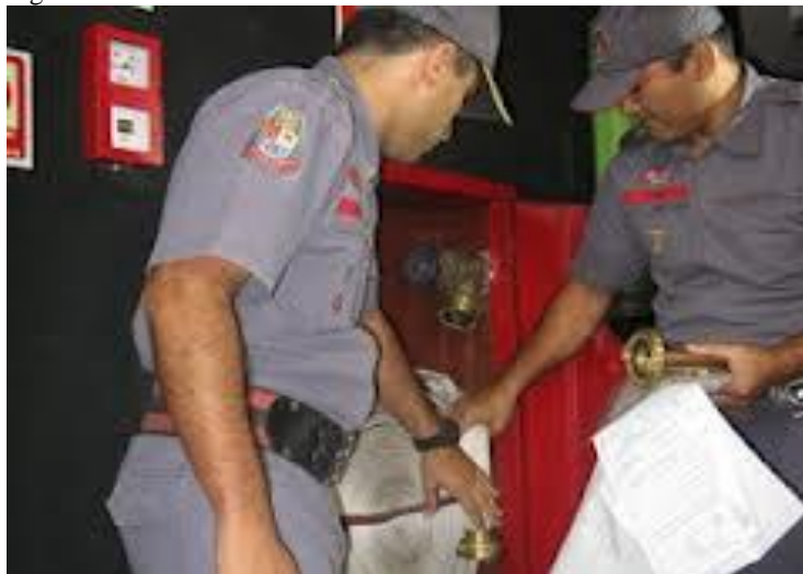
Figura 12 - Bombeiros do Estado de São Paulo realizando vistoria em SHP.
