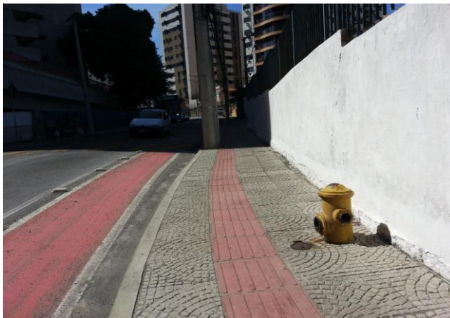
Figura 4 - Hidrante ao lado de edificação no bairro Agronômica: S 27°34'30" e W 48°32'20".
