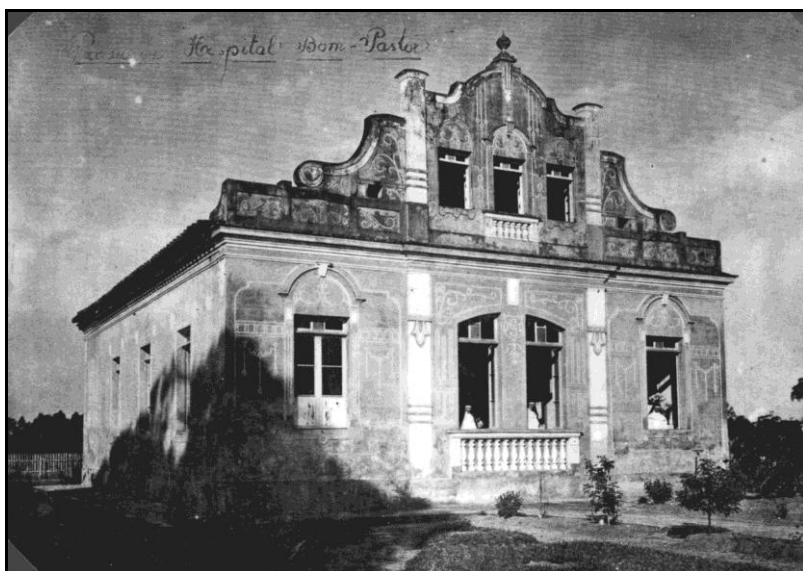
Figura 19 – Antiga sede do hospital Bom Pastor - Araranguá (1956)
