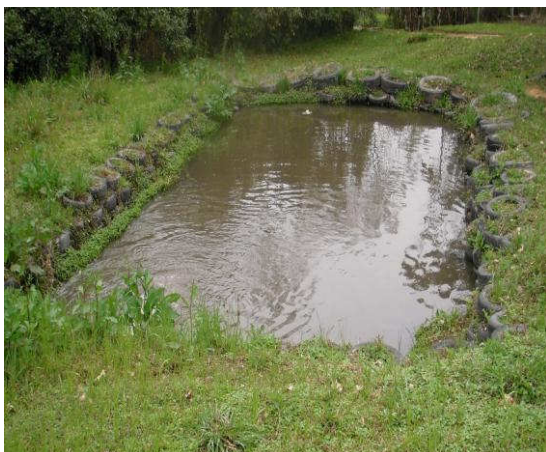
Figura 16. Lagoa de decantação
