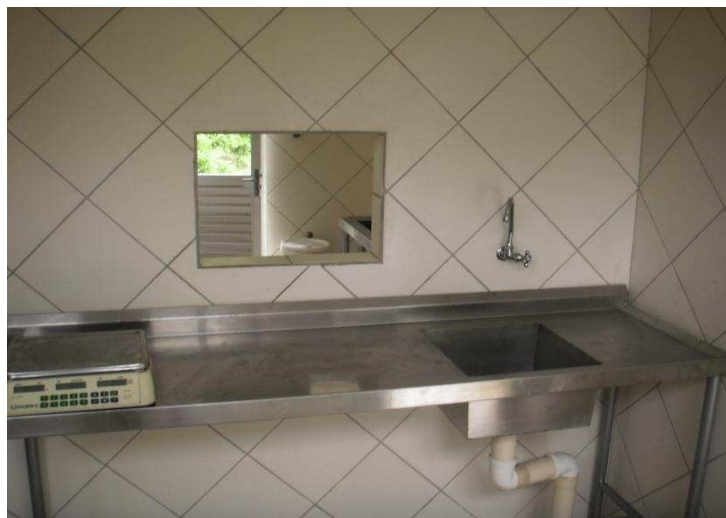
Figura 18. Óculo que separa a área suja da limpa (visualizado da área limpa)
