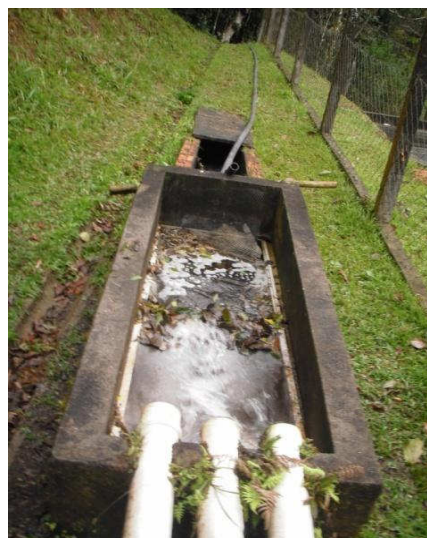
Figura 8. Caixa de inspeção para reter areia Figura 9. Caixa de inspeção para reter folhas
