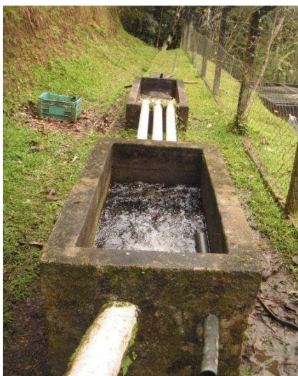
Figura 8. Caixa de inspeção para reter areia Figura 9. Caixa de inspeção para reter folhas
