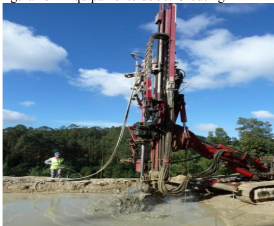
Figura 15 – Equipamento de Jet Grouting
