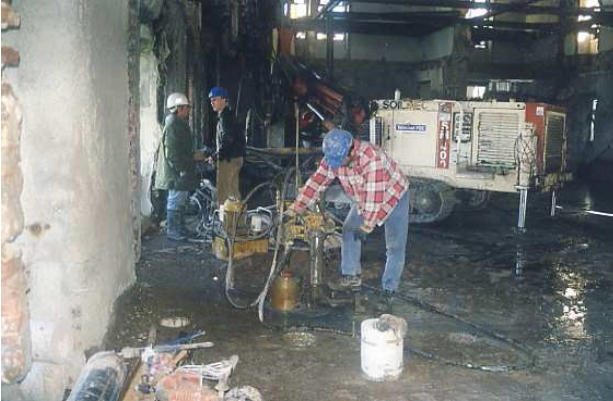
Figura 28 – Furação de laje
