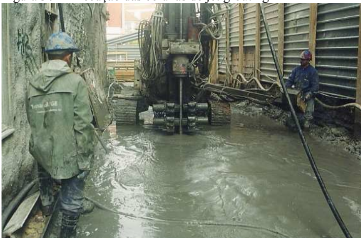
Figura 30 – Execução das colunas de jet grouting
