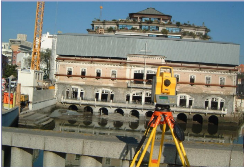
Figura 31 – Controle de recalque
