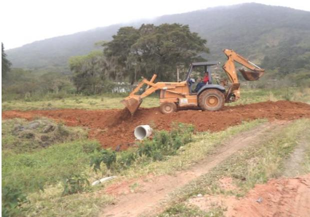
Figura 15 – Implantação de tubo no canal de drenagem no acesso à Estrutura 51.
