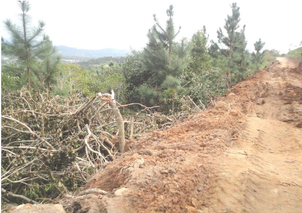
Figura 21 – Galharia disposta ao longo do vão entre as Estruturas 58-59.
