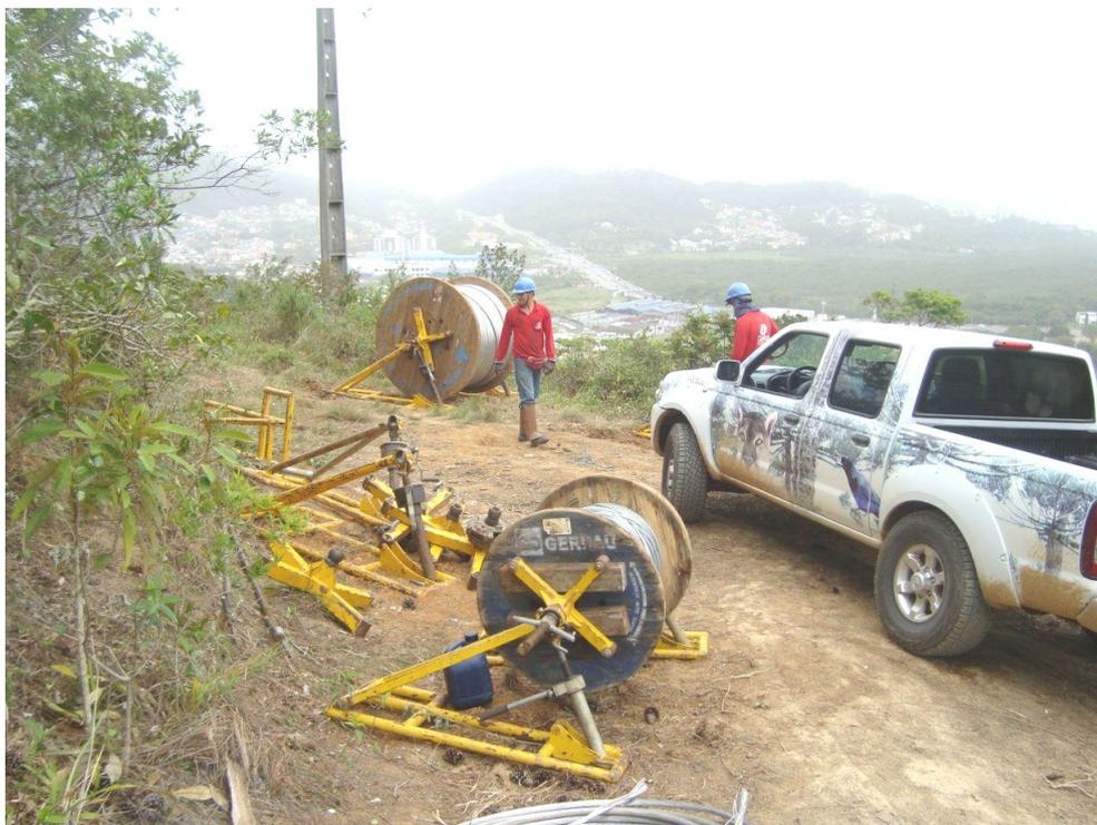
Figura 14 – Lançamento de cabos na Estrutura 59.
