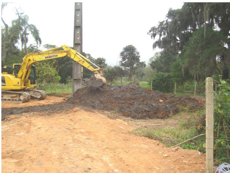
Figura 13 – Solo removido da escavação para implantação da Estrutura 51.
