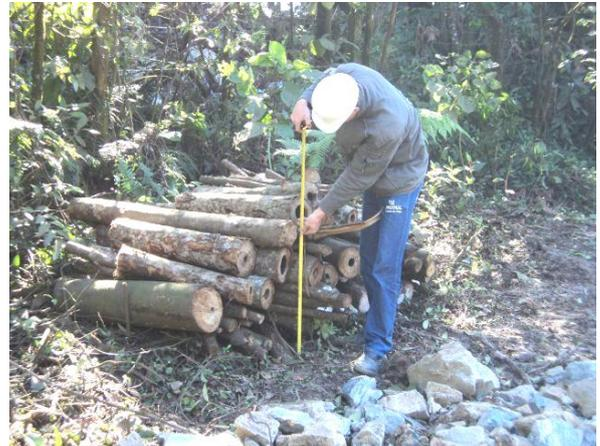
Figura 23 – Mensuração da madeira suprimida no vão entre as Estruturas 58-59.
