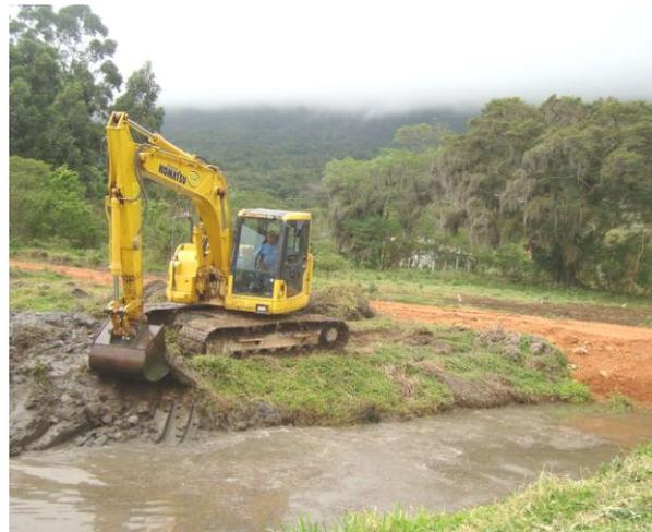
Figura 16 – Abertura do canal de drenagem no acesso à Estrutura 51.
