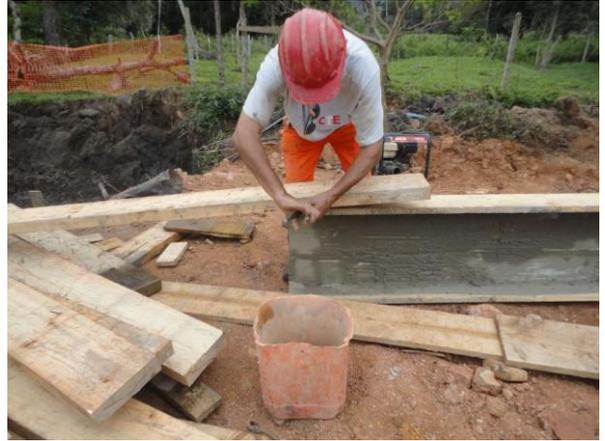
Figura 27 – Recolhimento dos pregos utilizados na caixaria da Estrutura 51.
