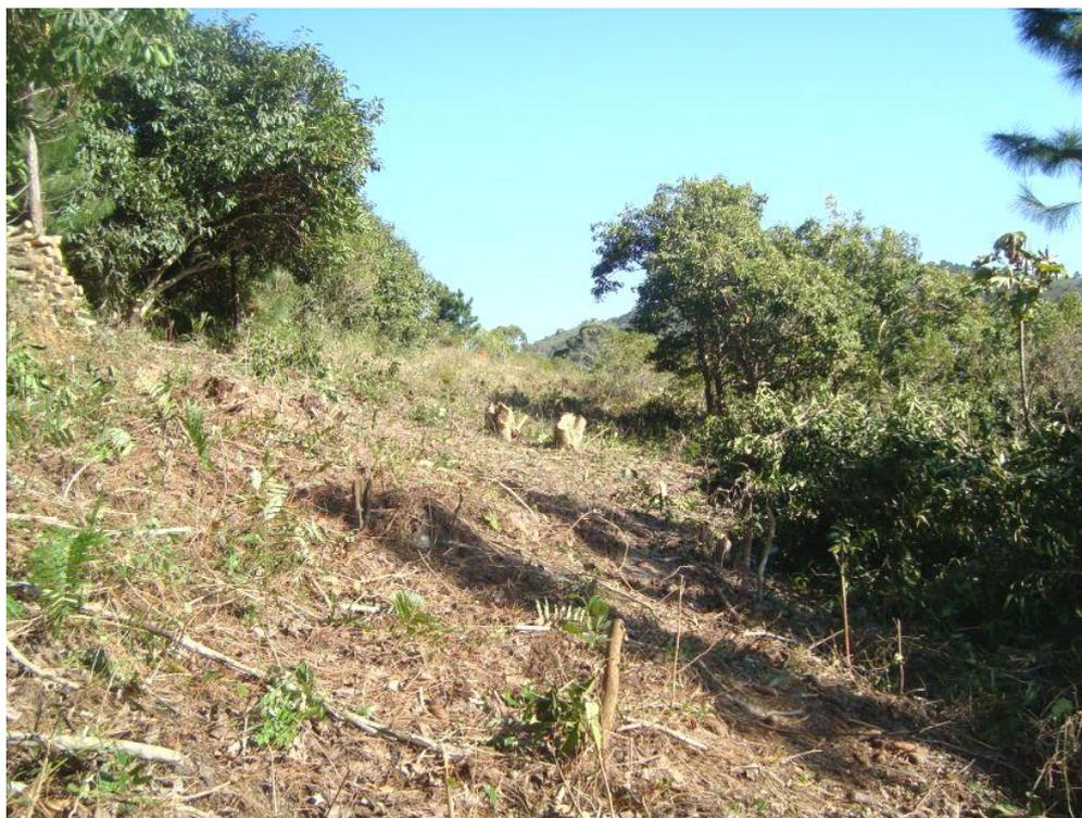
Figura 1 – Desmatamento para abertura de acesso às Estruturas 58-59.
