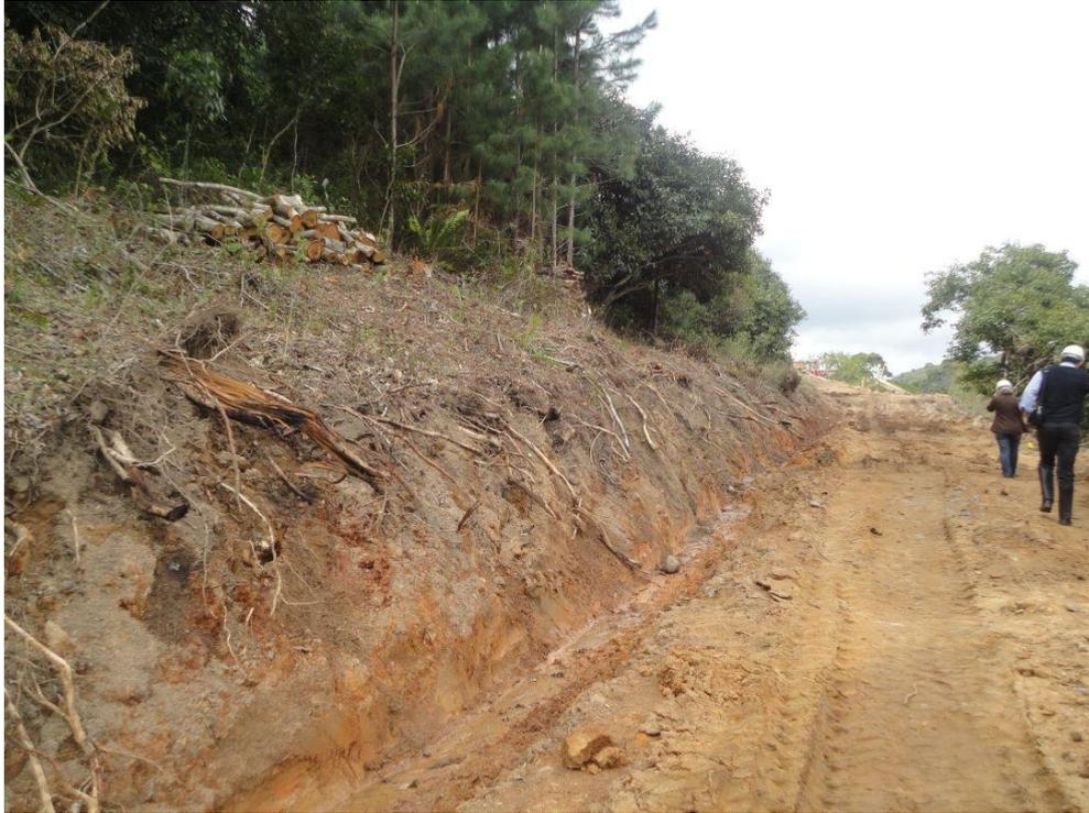
Figura 3 – Interferência sobre o solo para abertura do trecho de acesso entre as Estruturas 58-59.
