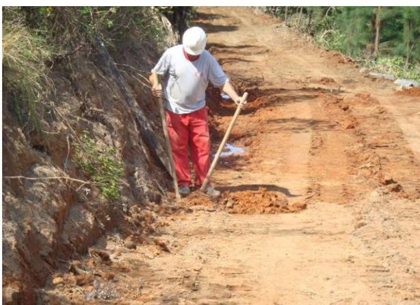
Figura 19 – Abertura de canal de drenagem no acesso entre as Estruturas 58-59.
