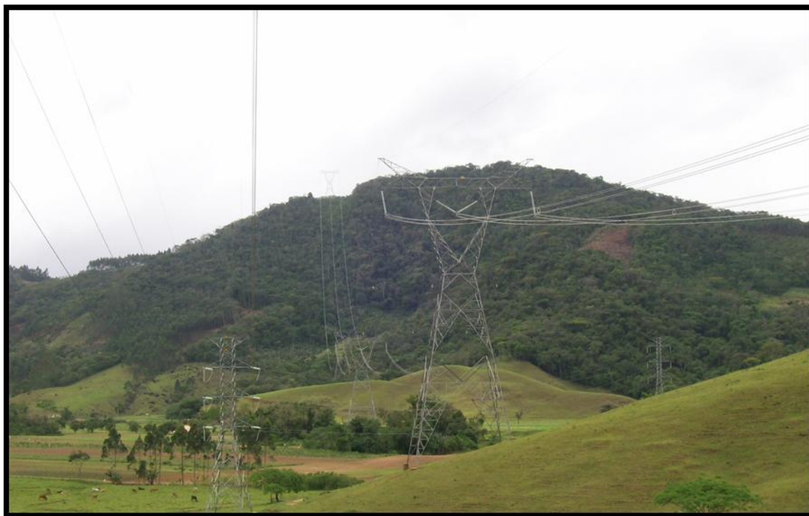
Figura 1. Linha de Transmissão. Fonte: Eletrosul, 2011.
