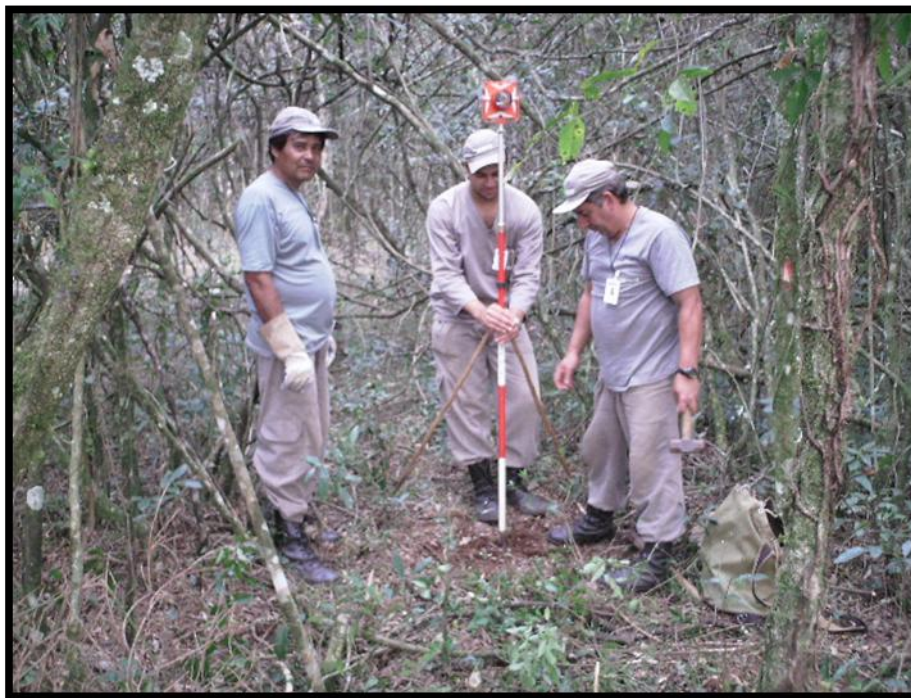
Figura 2. Técnicos realizando levantamento topográfico. Fonte: Eletrosul, 2011.
